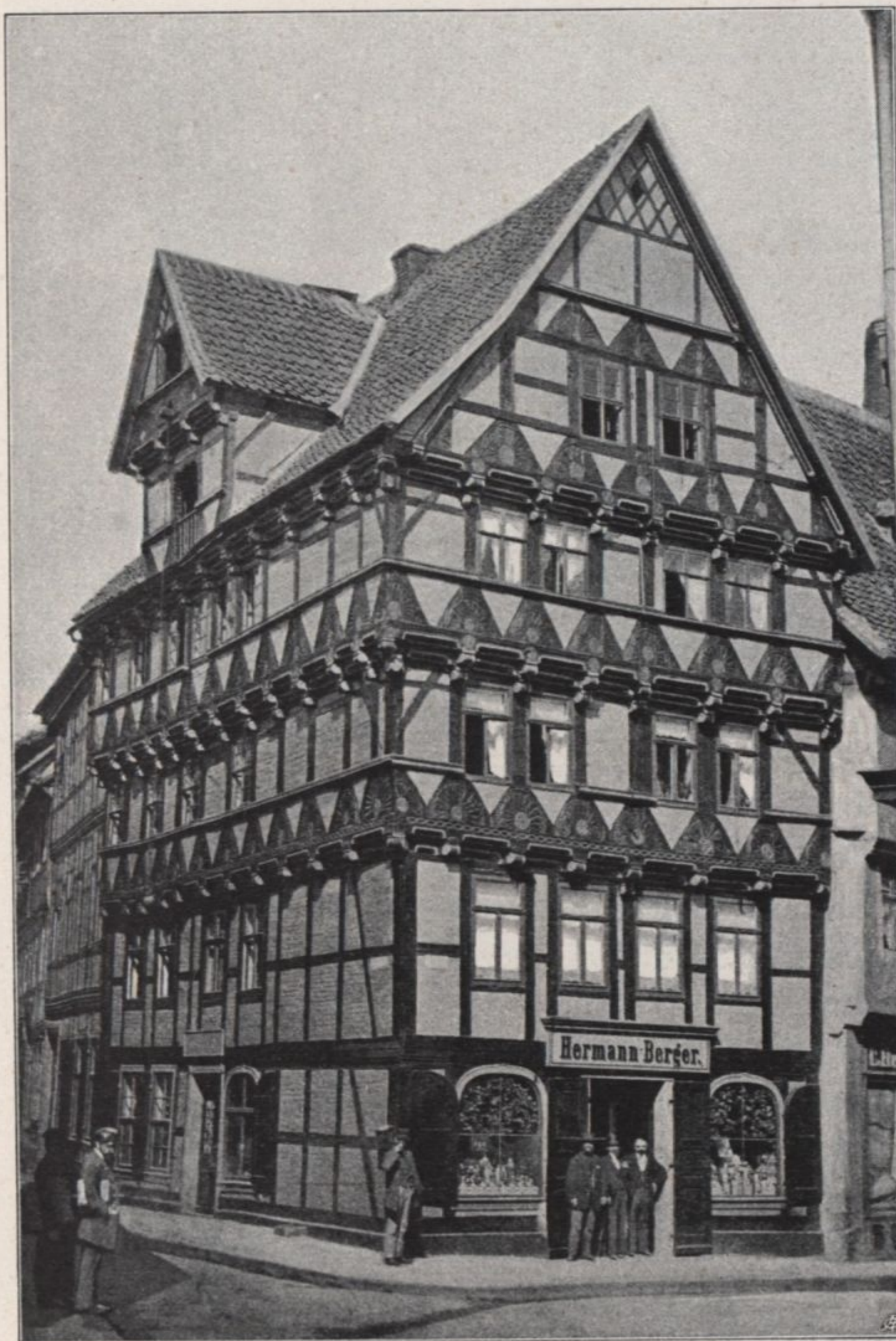
Eckhaus in Halberstadt (in den Untergeschossen umgebaut)
