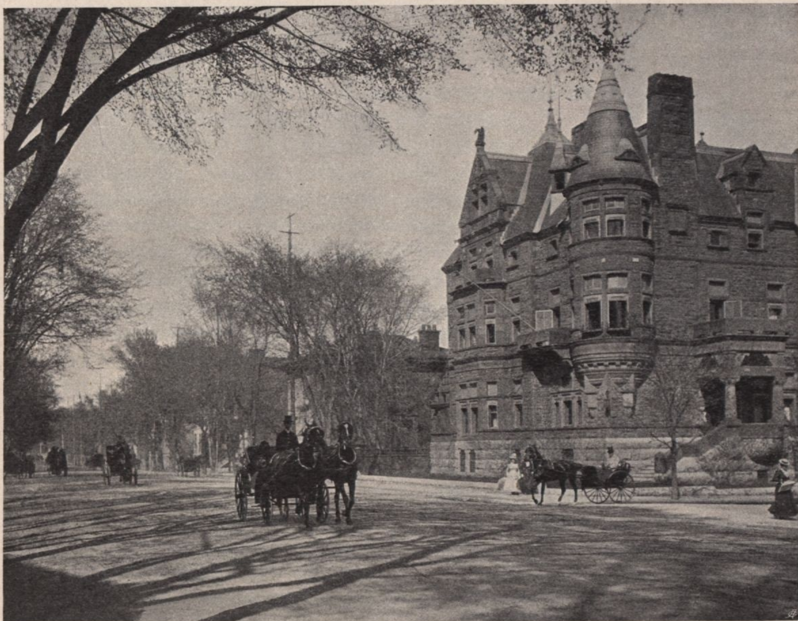
Parkstraße in Montreal (Kanada)
