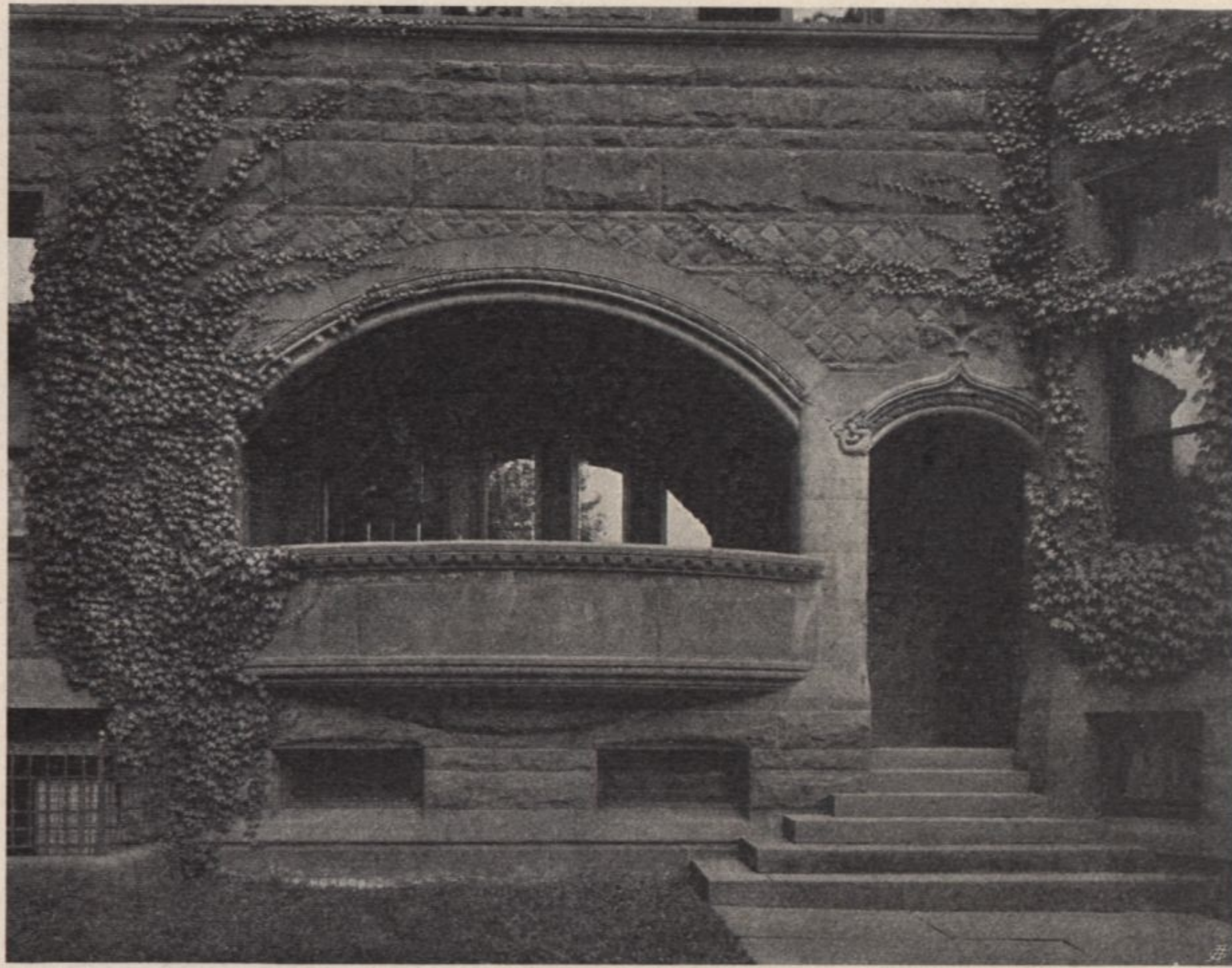
Hauseingang in Albany (N. Y.). H. H. Richardson, Architekt
