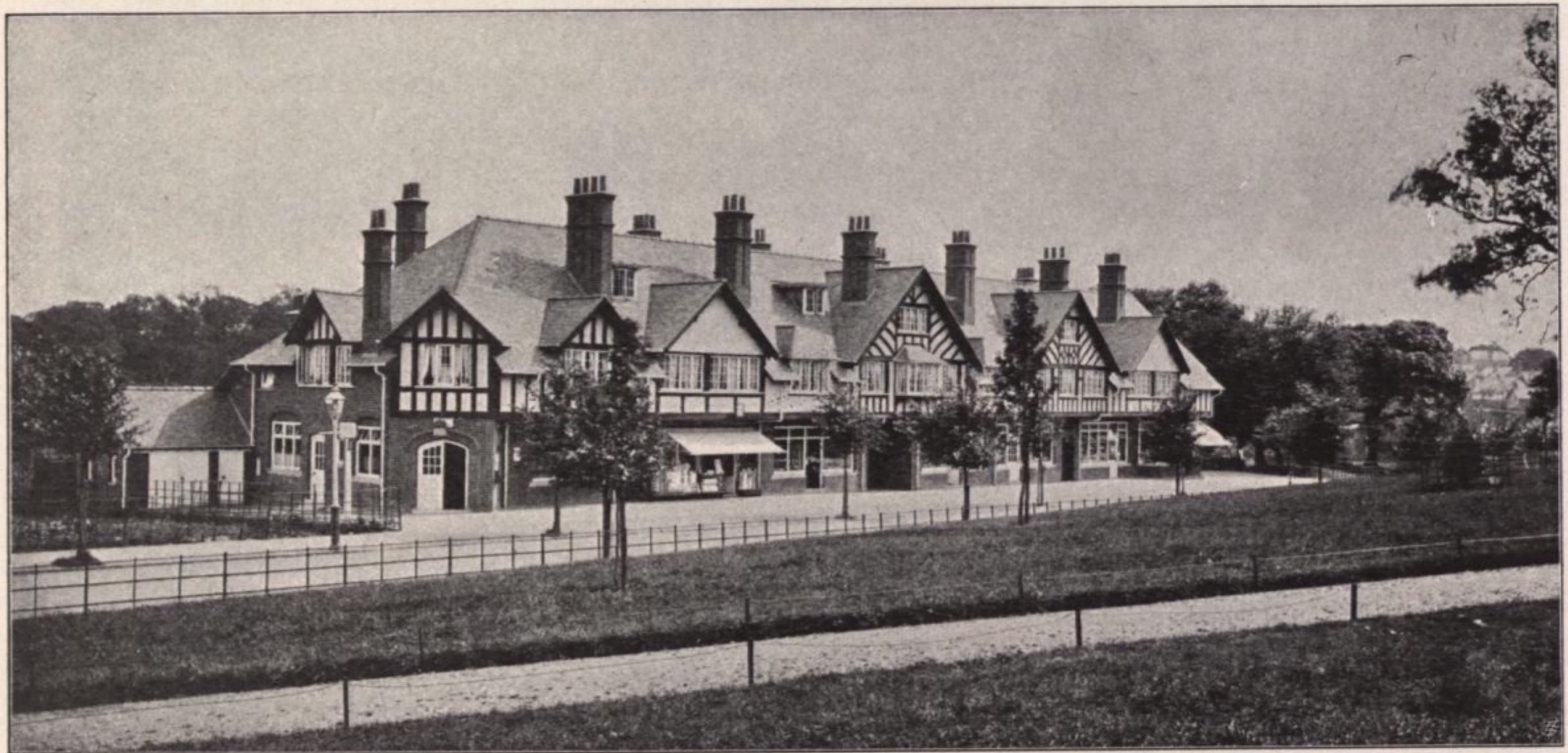
Abb. 21. Bournville, Postgebäude und Verkaufsladen. H. B. Tylor, Architekt
