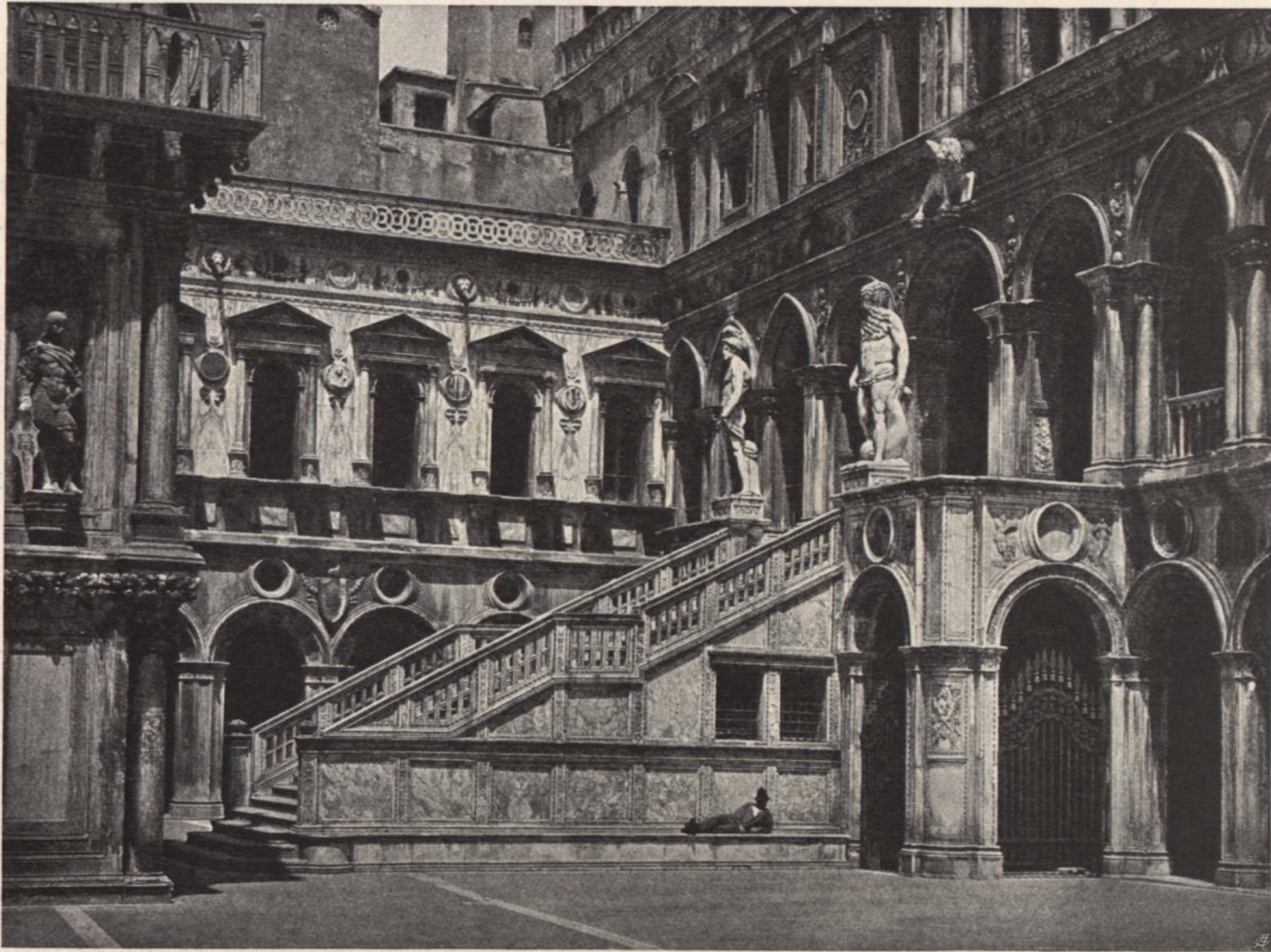
Marmortreppe im Hof des Dogenpalastes, Venedig
