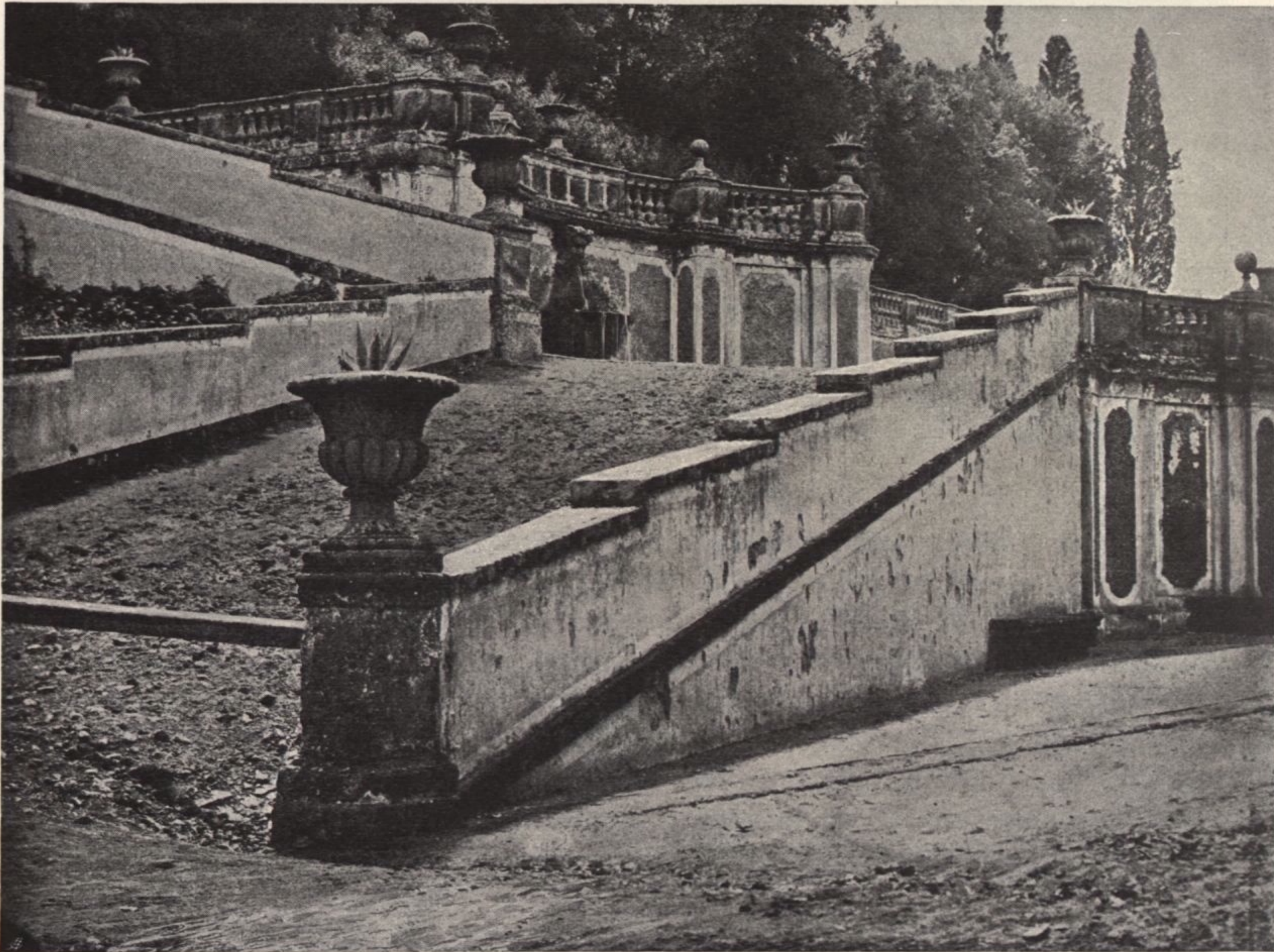
Villa Conti Tarlonoia, Frascati, Rampenanlage
