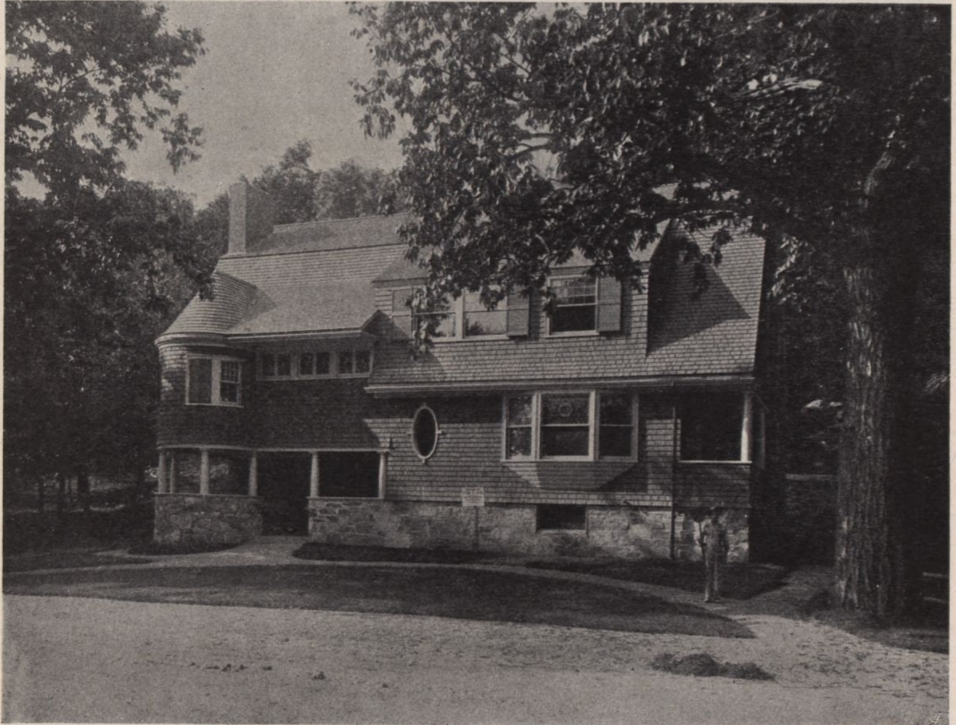
Wohnhaus in Brookline (Mass.), Bruchstein und Holz, verschindelt
