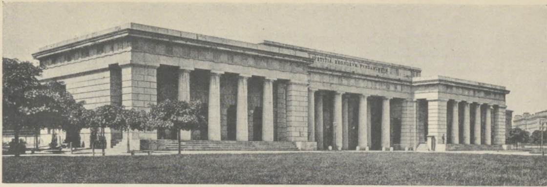
Abb. 1. Das Burgtor (Architekt Peter von Nobile) vom Heldenplatz gesehen.
