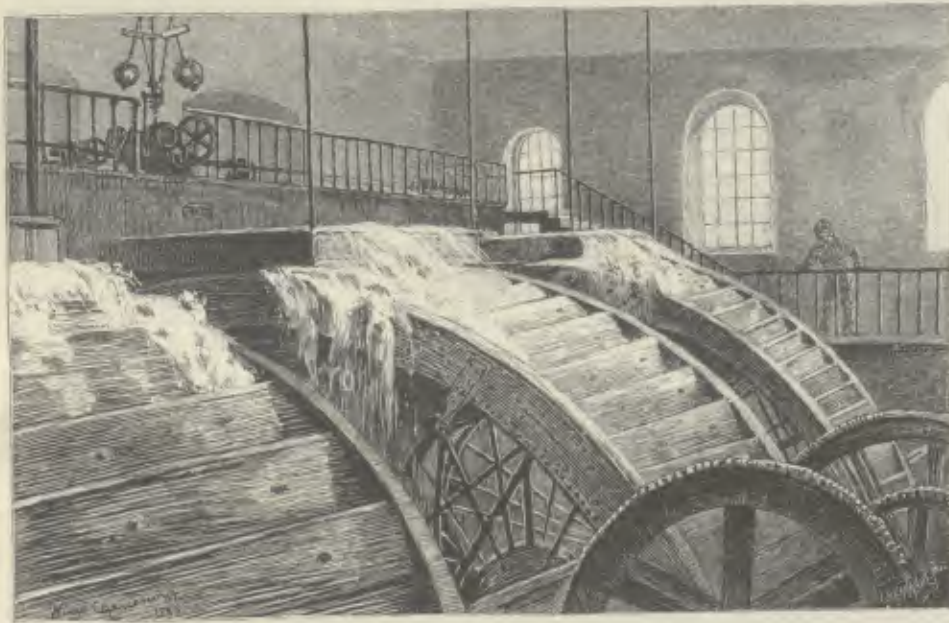
Das Wasserwerk der Spinnfabrik in Trumau.
