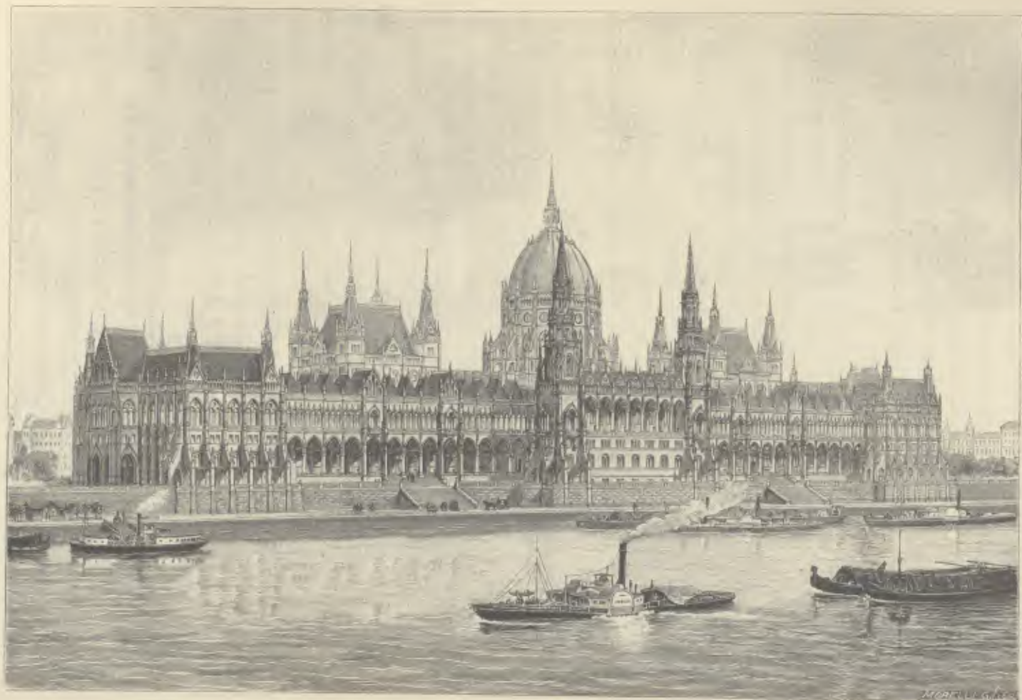
Das neue Reichstagsgebäude.
