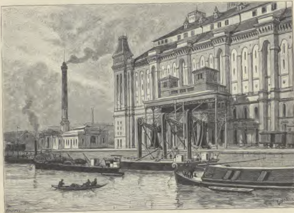
Der Elevator am Donauufer.
