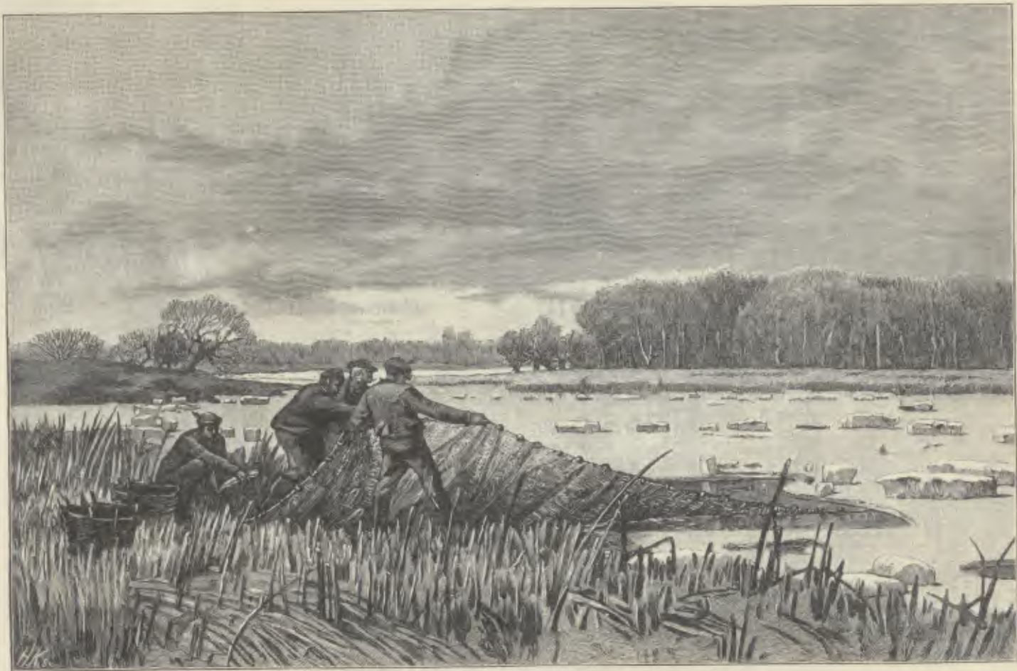
Reparaturarbeiten auf der Baag im Winter.
