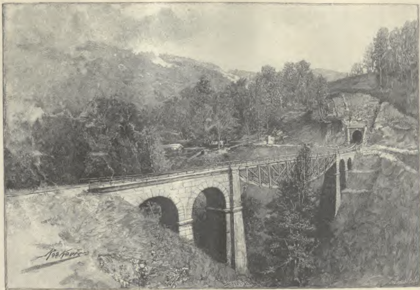
Überführung und Tunnel bei Kenia.
