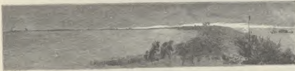
Damm zwischen der Hochflut und dem Binnenwasser.
