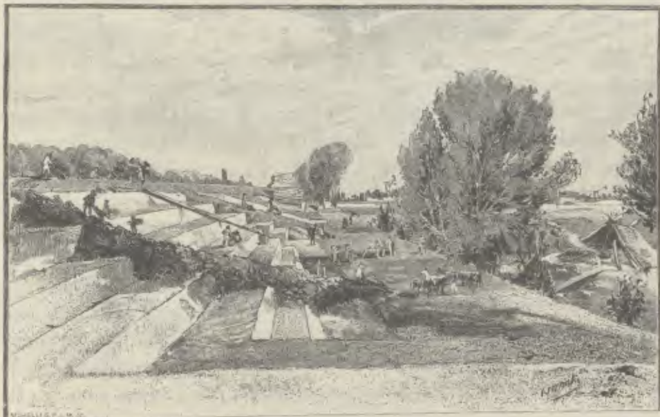
Arbeit auf dem Damm.
