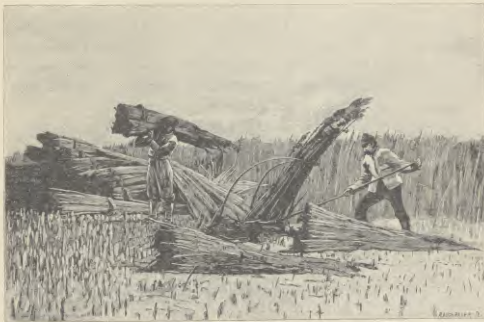
Das Schneiden des Rohres.
