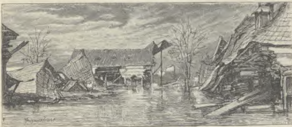
Eingestürzte Häuser in Szegedin bei der Überschwemmung von 1879.
