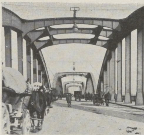
Floridsdorfer Brücke, Fahrbahn.
