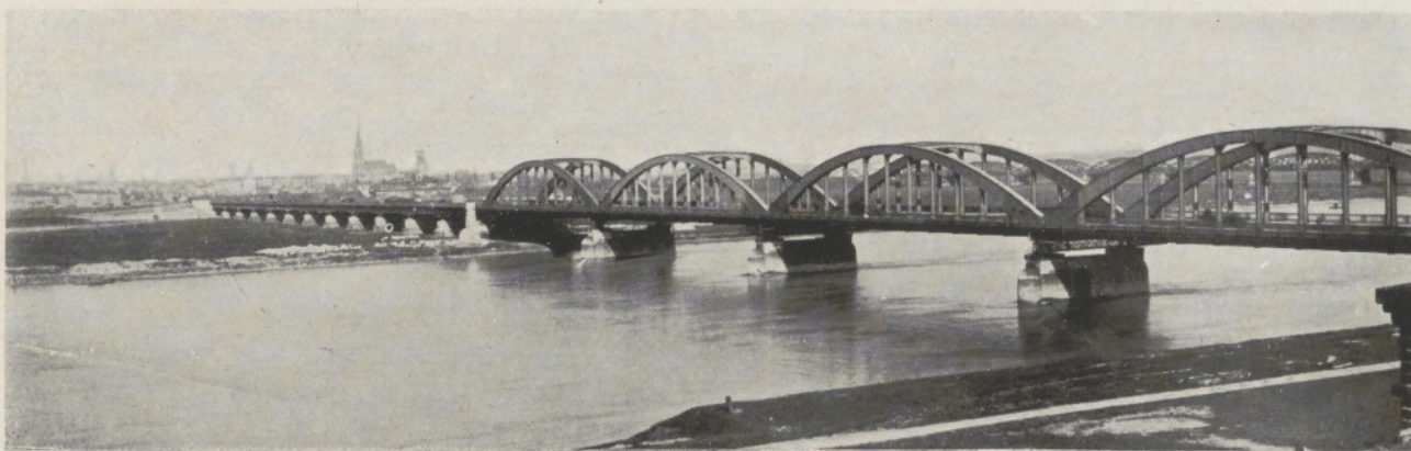
Floridsdorfer Brücke. Gesamtansicht.
