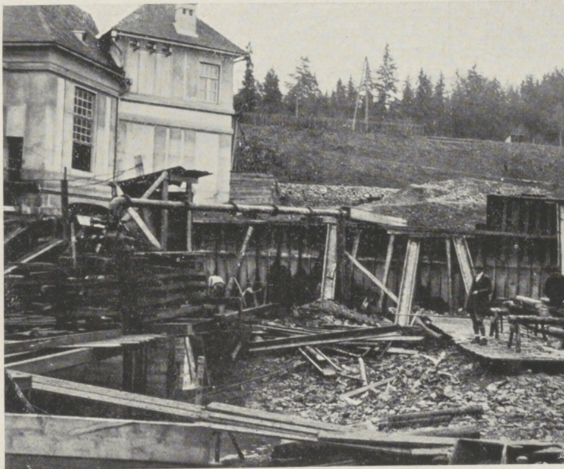
Stauwehranlage in Passering. Ausgeführt von der Fa. Bulfon.
