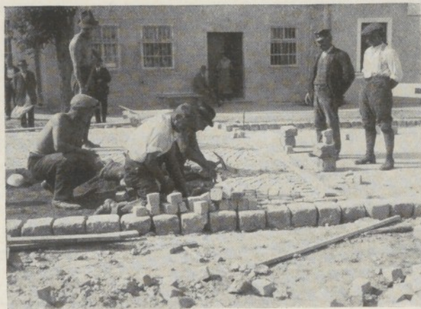
Kleinsteinpflasterungen zwischen Saumreihen aus Großsteinen in einer Gefällsstrecke. Rechts anschließend Betonpflaster. Stockerau 1927.
