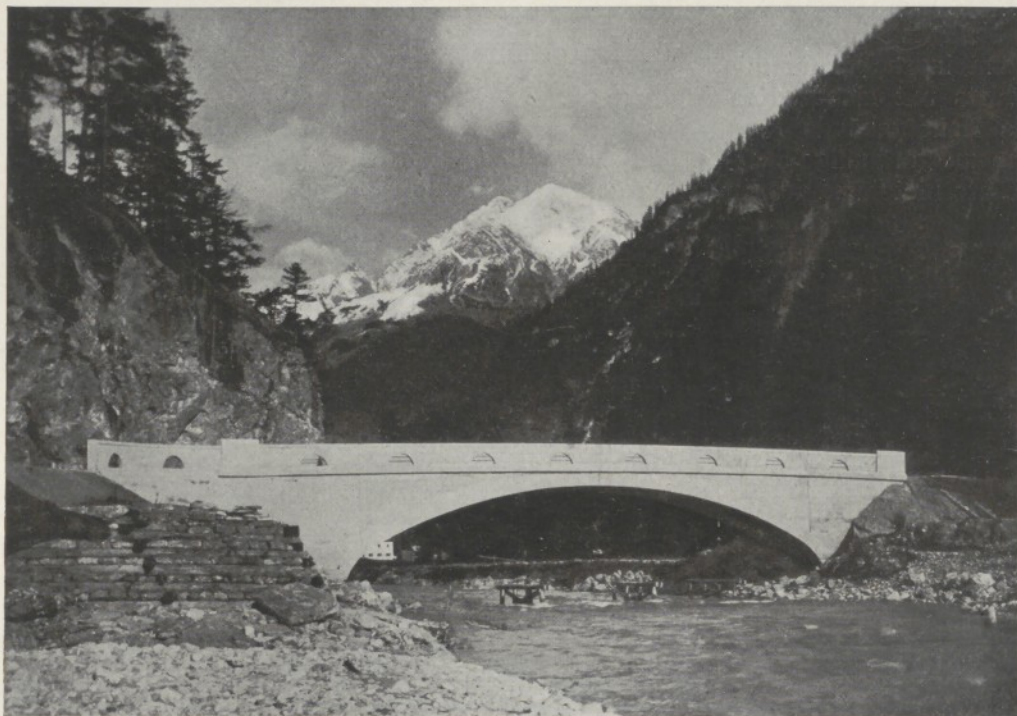
Abb. 1. Stockacher Lechbrücke — Lechtalstraße.
