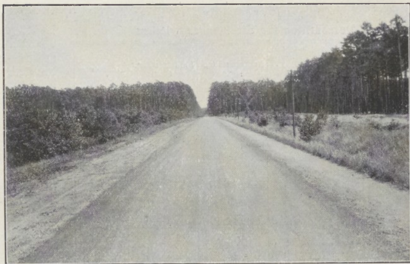
Landstraße, hergestellt mit Mexiko-Ebano-Bitumen.
