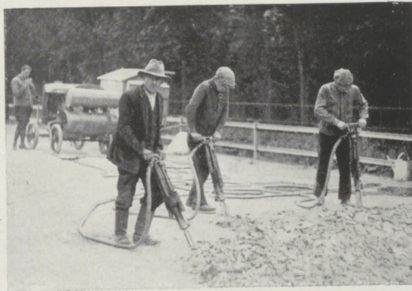
Abb. 2. Aufreißen von Betonstraßen.
