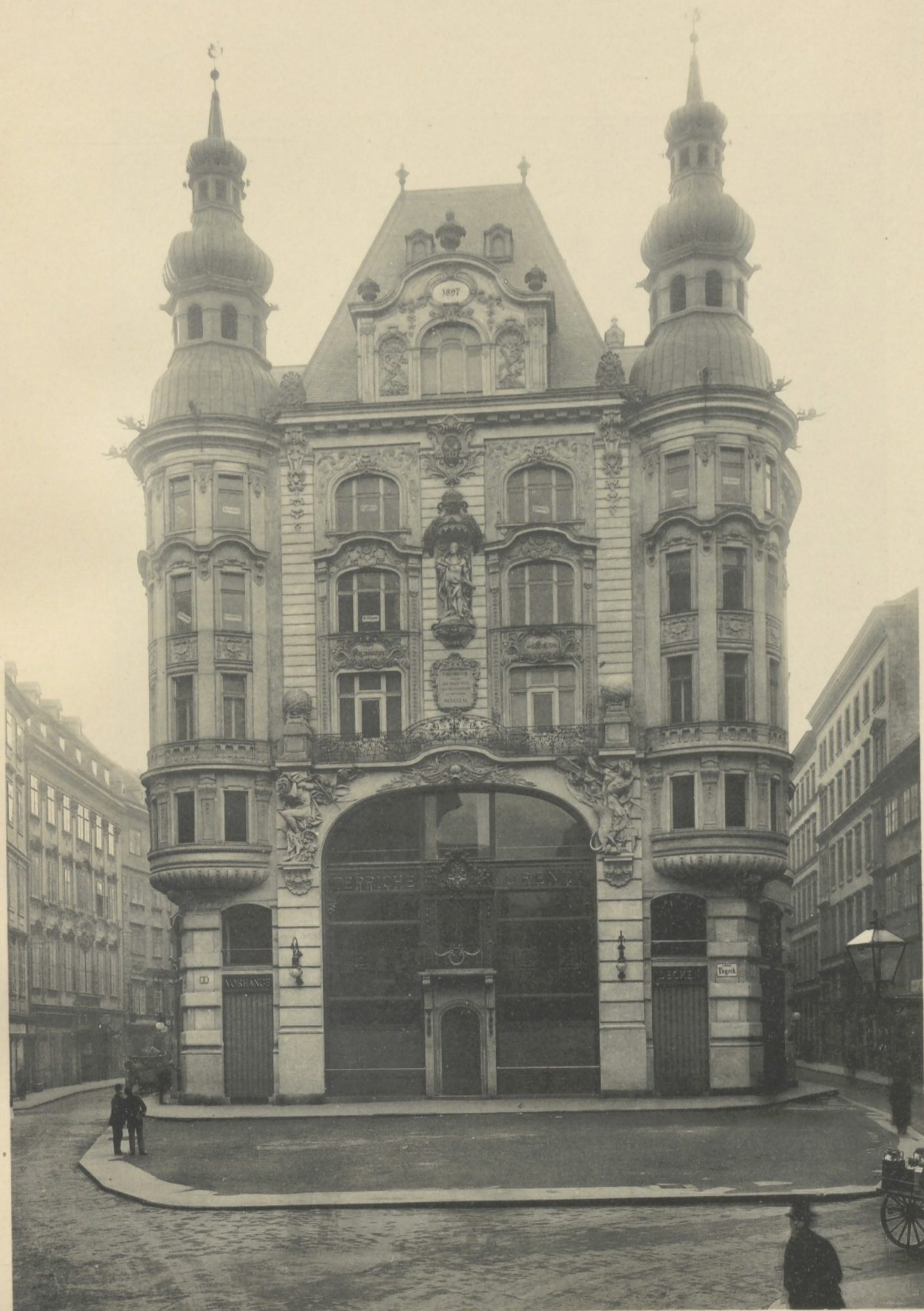
»REGENSBURGERHOF« IN WIEN, I., LUGECK. ARCHITEKT K. K. BAURATH FRANZ R. V. NEUMANN, WIEN.
