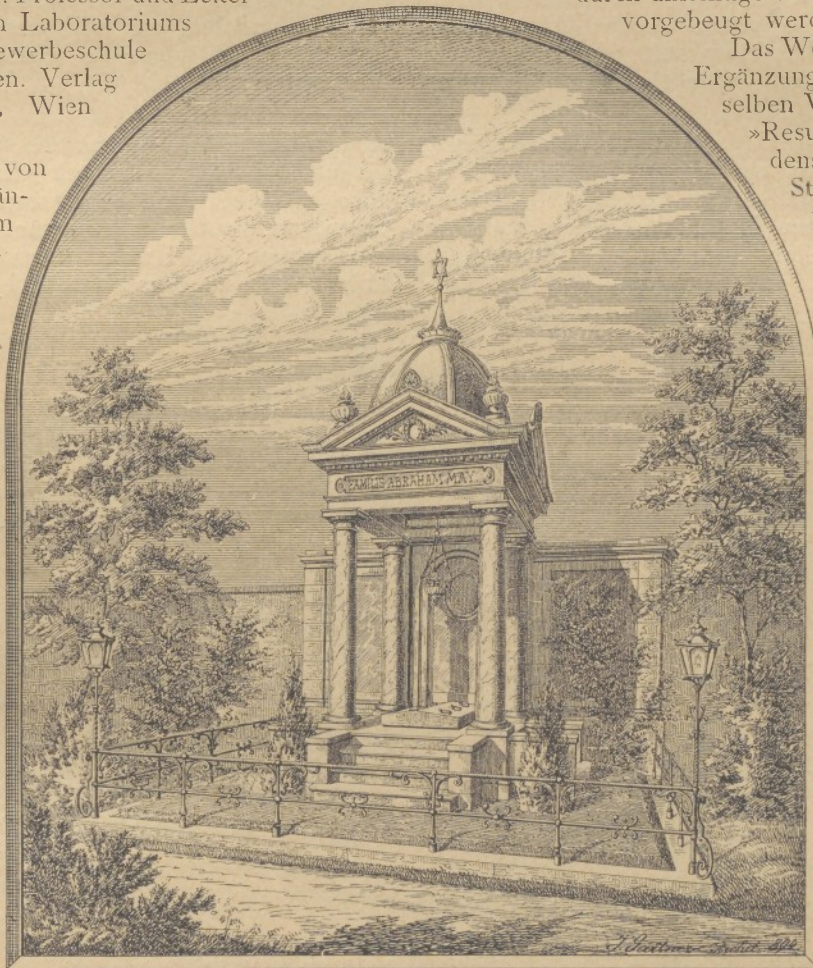
Grufte der Familie May am Centralfriedhofe in Wien. Architekt J. Gartner in Wien.
