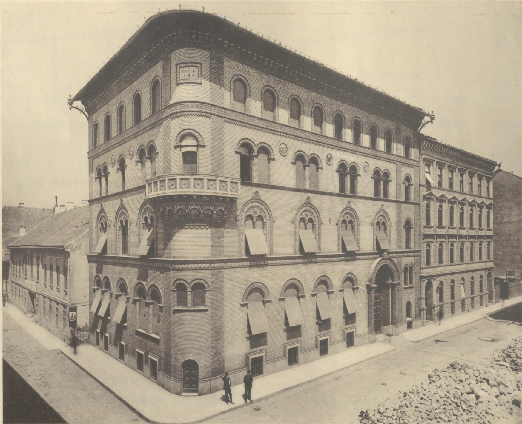
Wohnhaus Ecke Trefort- und Eszterházy-Gasse in Budapest.
