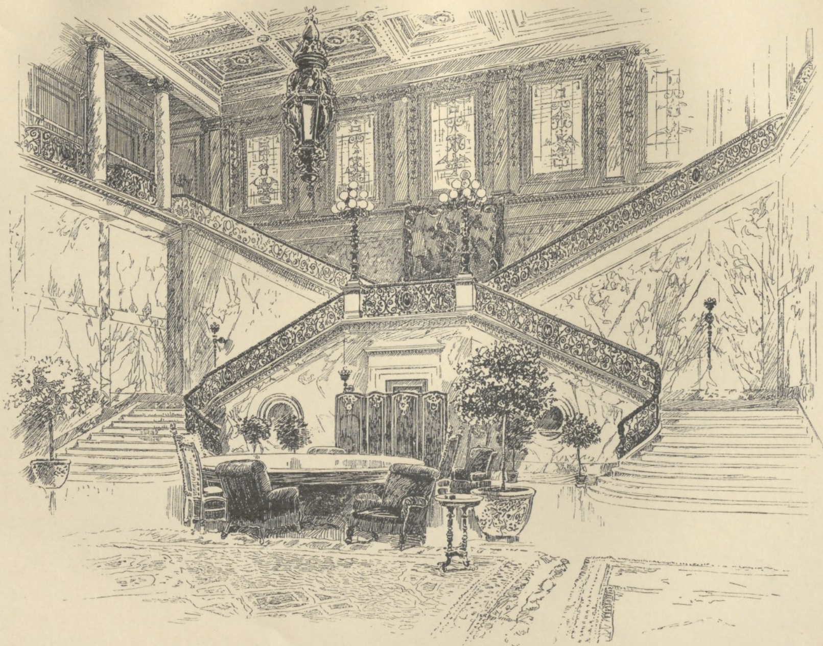
Grosse Stiegenhalle des „Metropolitan-Club“ in New-York.
