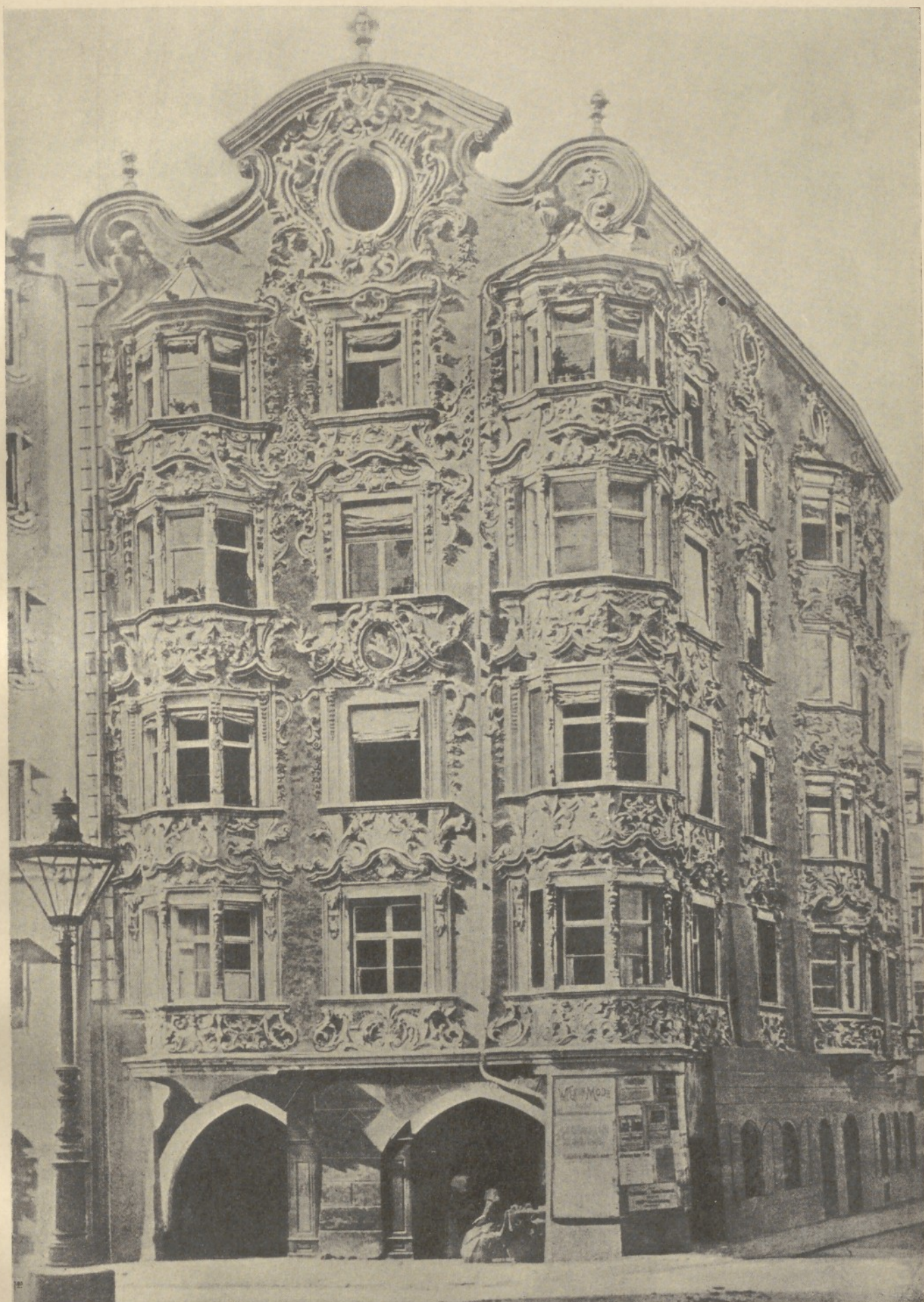
Altes Wohnhaus in Innsbruck, Theresienstrasse (derzeit katholisches Casino).
