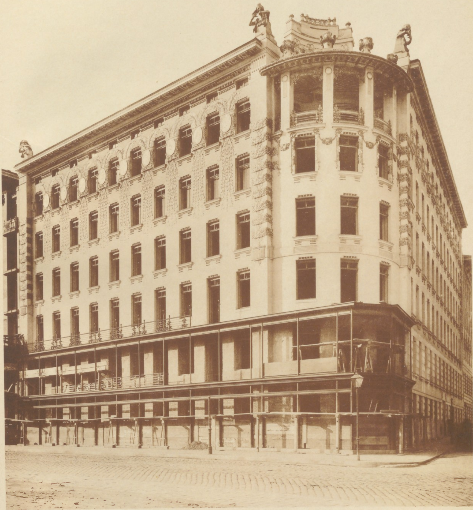
Wohnhaus in Wien, VI., Magdalenenstrasse 40. Architekt k. k. Oberbaurath Professor Otto Wagner in Wien.
