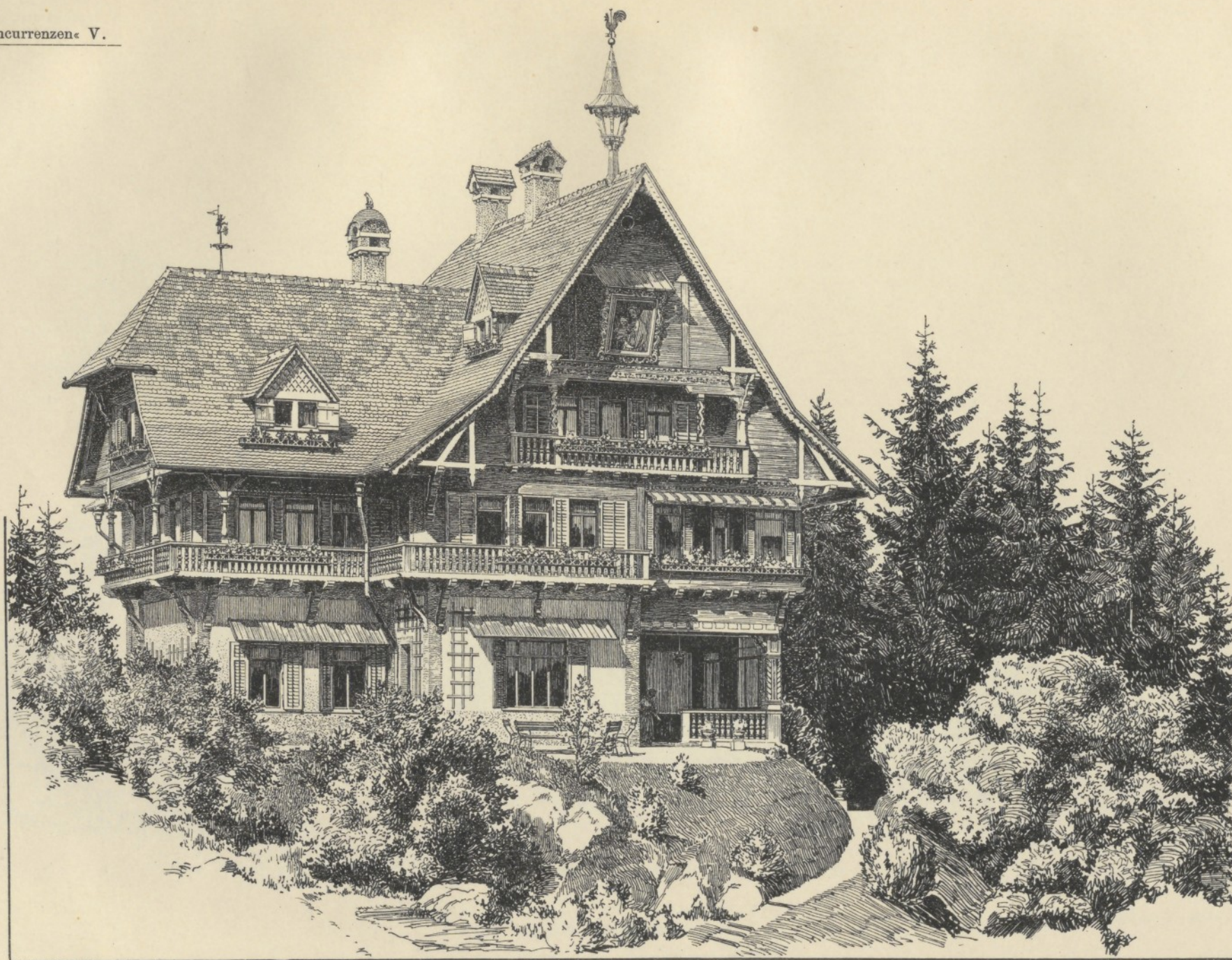
Villa Leibenfrost am Semmering. Architekt k. k. Baurath Franz Ritter v. Neumann in Wien.
