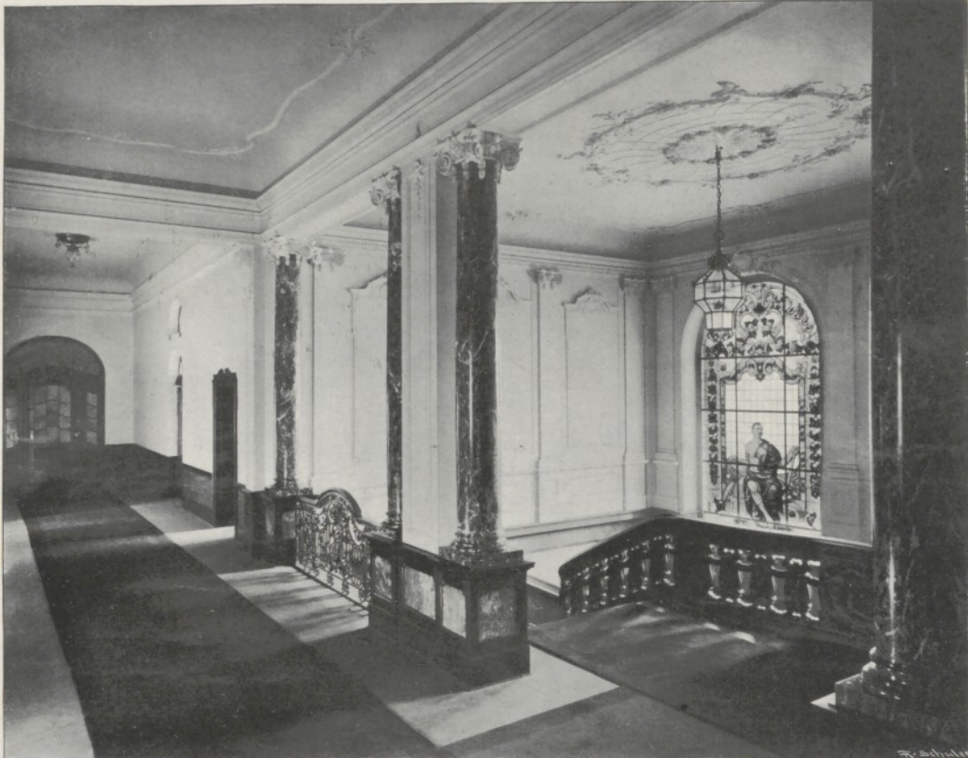
Das neue Staatsministerium in Berlin. Blick in das Treppenhaus.
