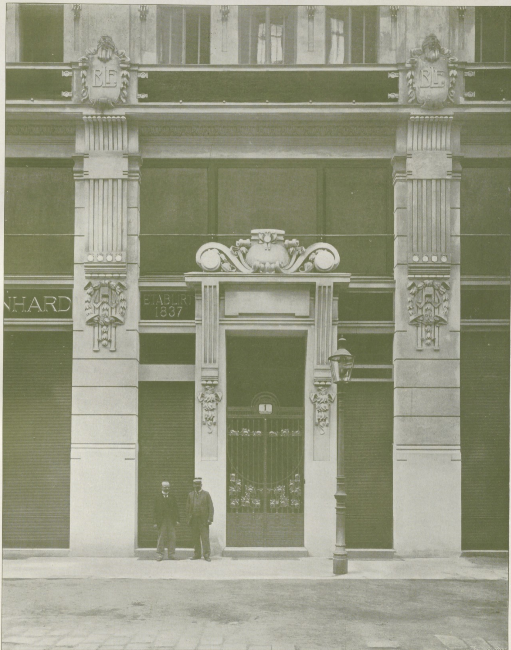
Wohn- und Geschäftshaus des Wiener Bürgerlade-Fonds in Wien. 3. Eingang.
