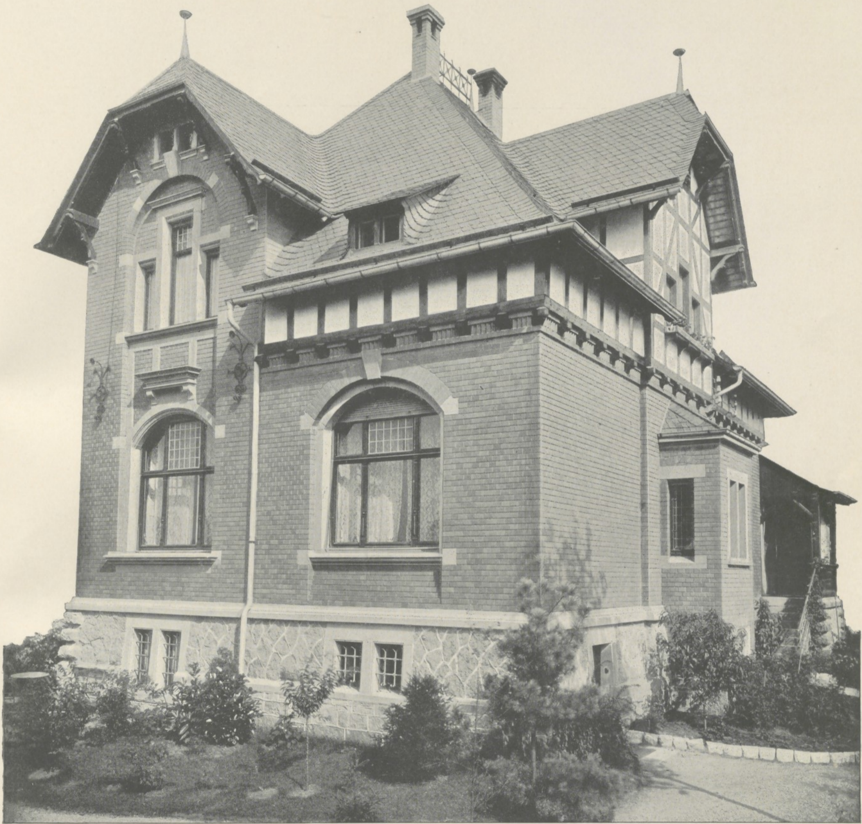
Architekt H. Metzendorf. ◇ ◇ ◇ ◇ ◇ ◇ ◇ ◇ EINFAMILIENHAUS IN AUERBACH a. d. B. ◇ ◇
