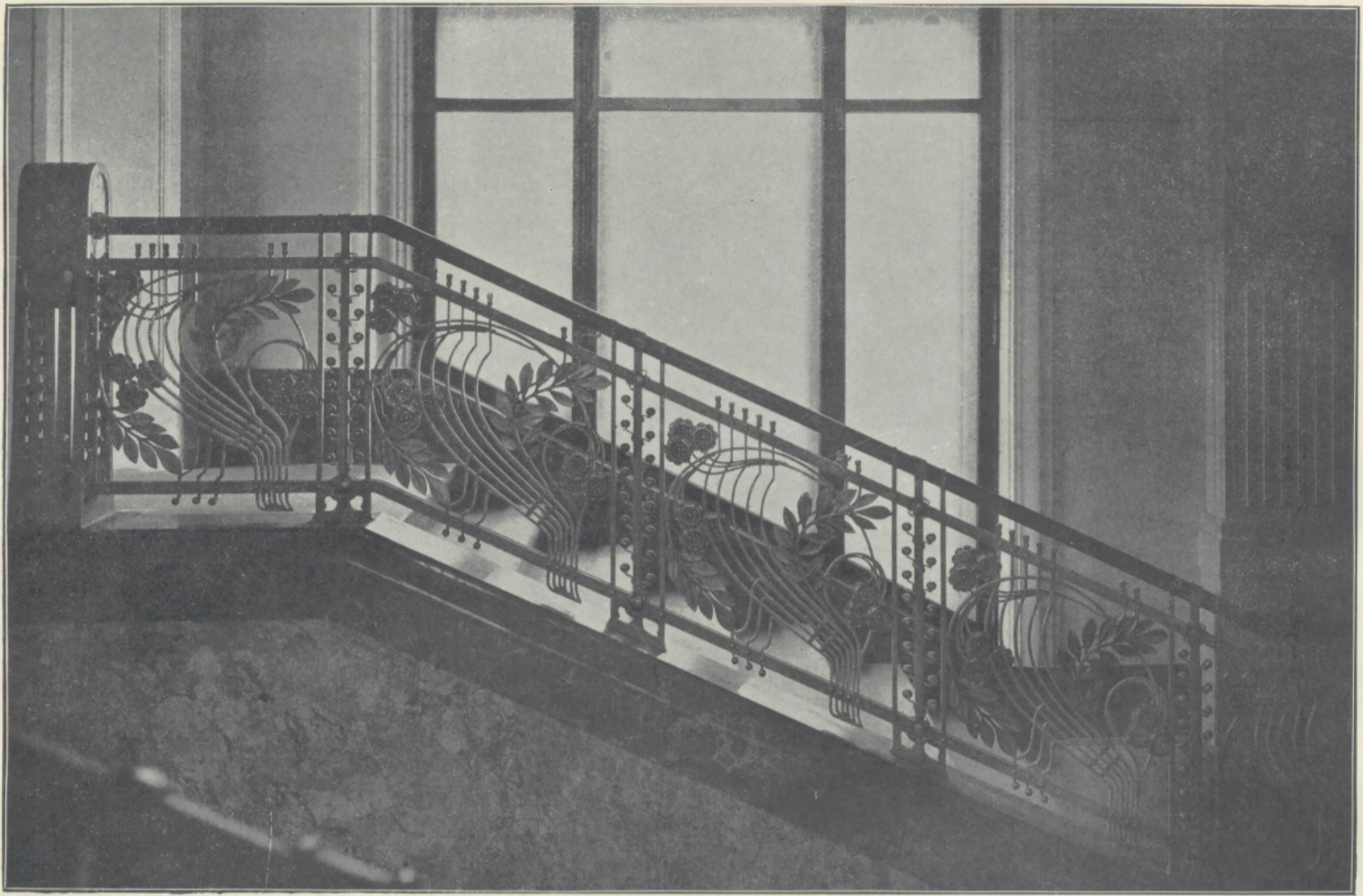
Hôtel Central in Prag: Treppenaufgang ins Foyer
