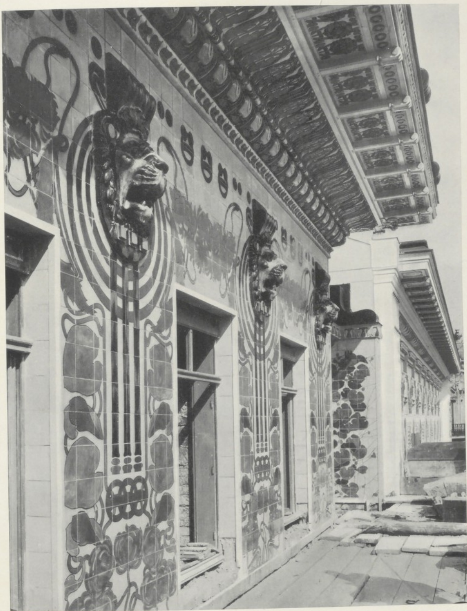
FASSADENSTÜCK DER HÄUSER AUF DER WIENZEILE (SEZESSIONSZEIT 1898—1900) FASSADENVERKLEIDUNG IN MAJOLIKAPLATTEN
