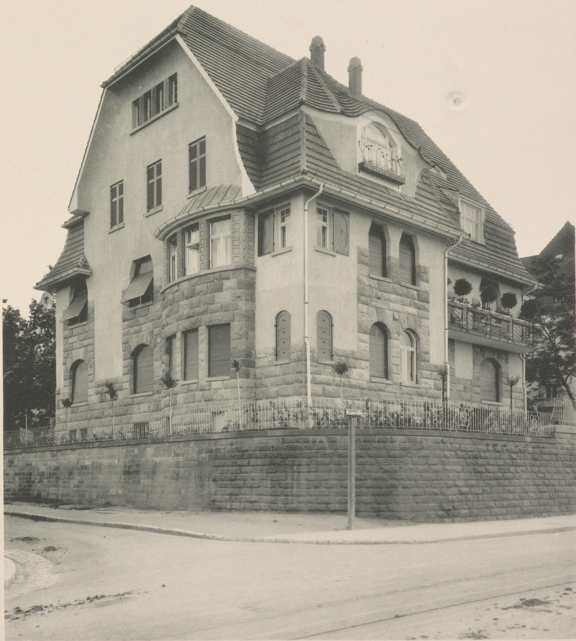
Architekten Hennings & Schweitzer. Villa in Stuttgart, Kanonenweg 58.
