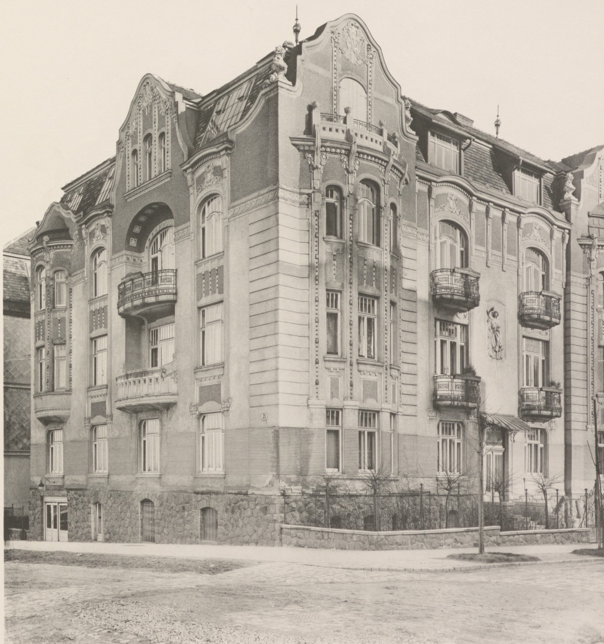
Architekt J. Reitzer Wohnhaus Karl Ludwigstraße 86.
