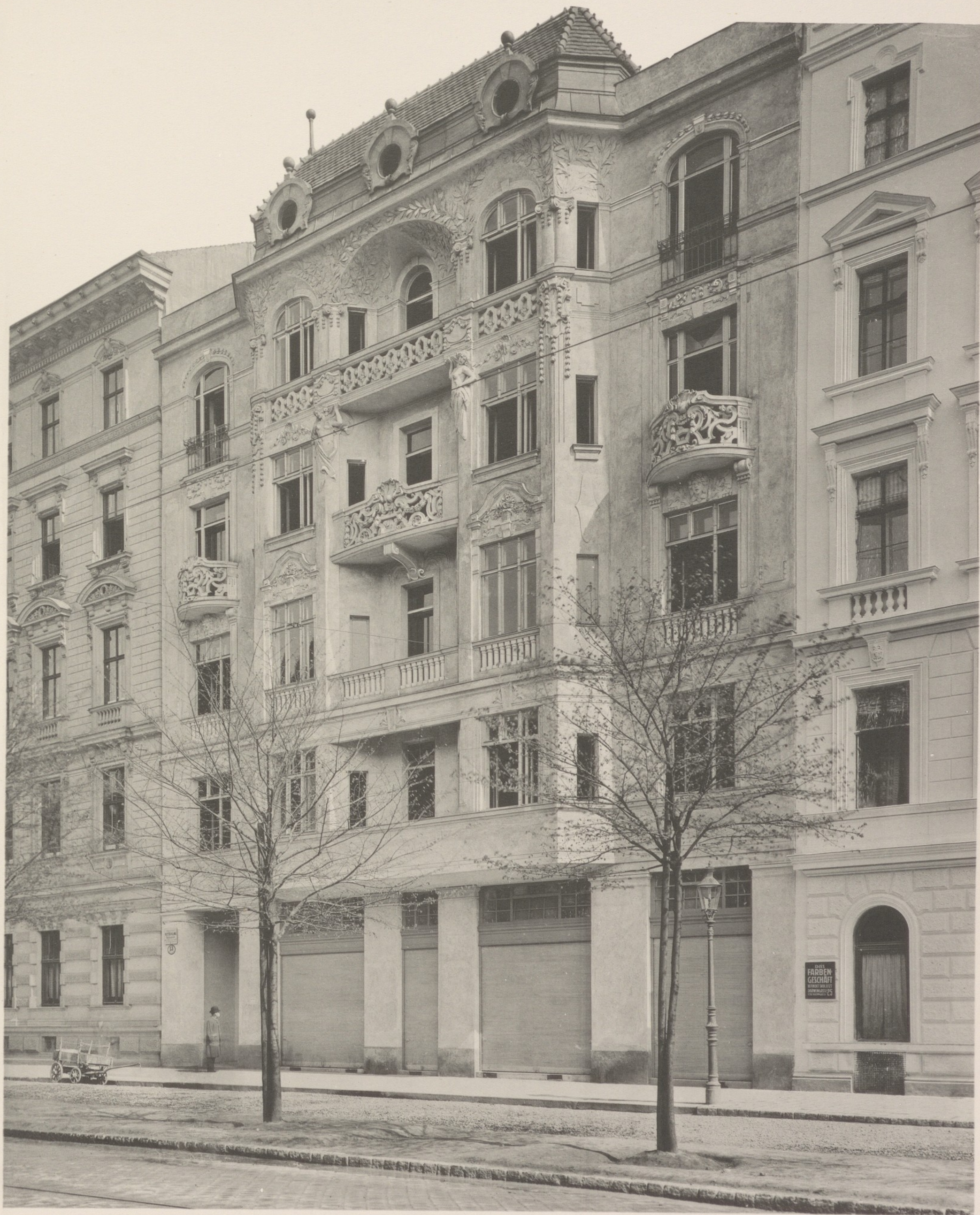
Architekt Viktor Klima Wohnhaus II., Kaiser Josefstraße 13.
