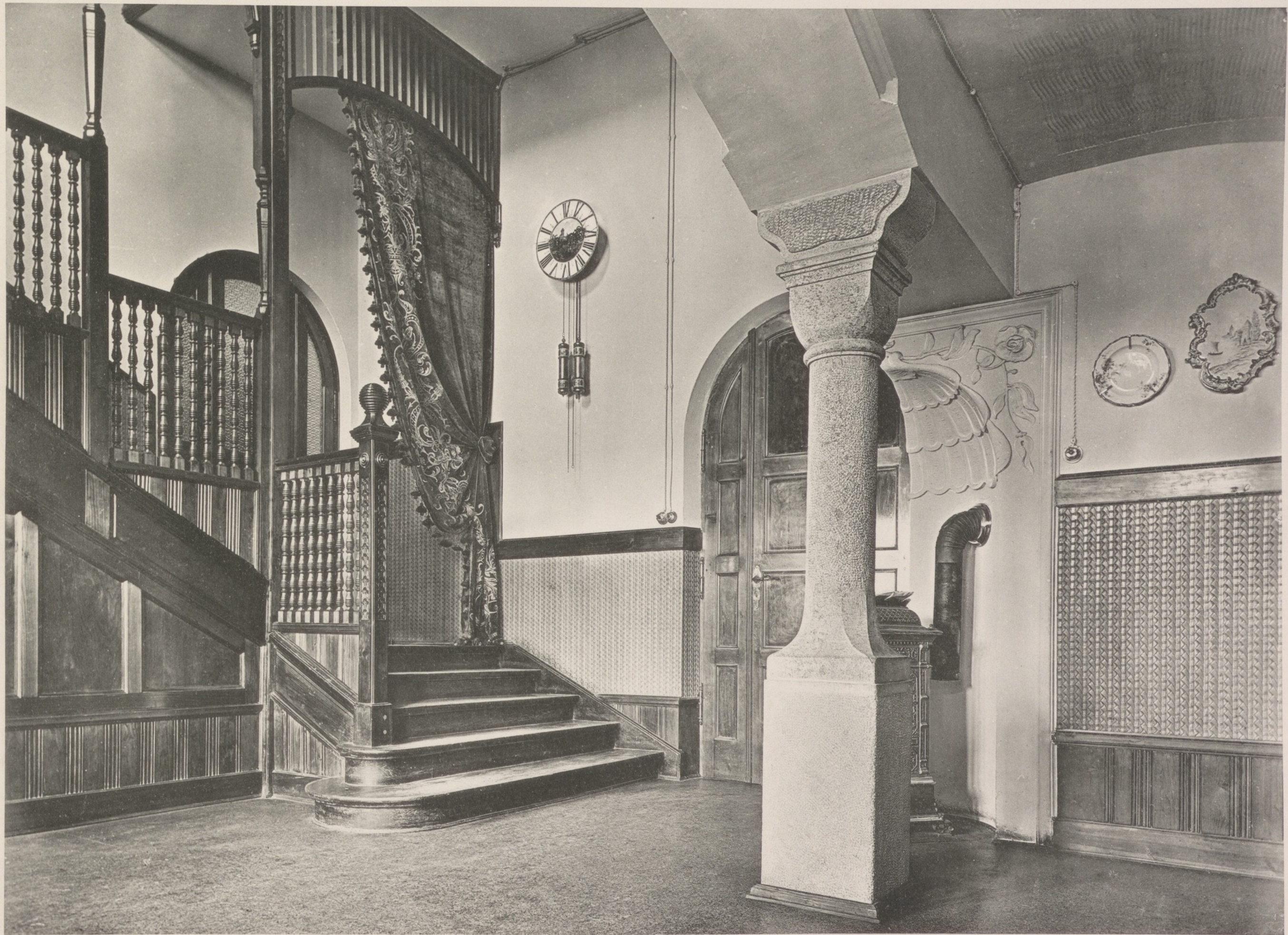
Architekt Martin Dülfer Innenraum, München, Prinz Ludwigshöhe.
