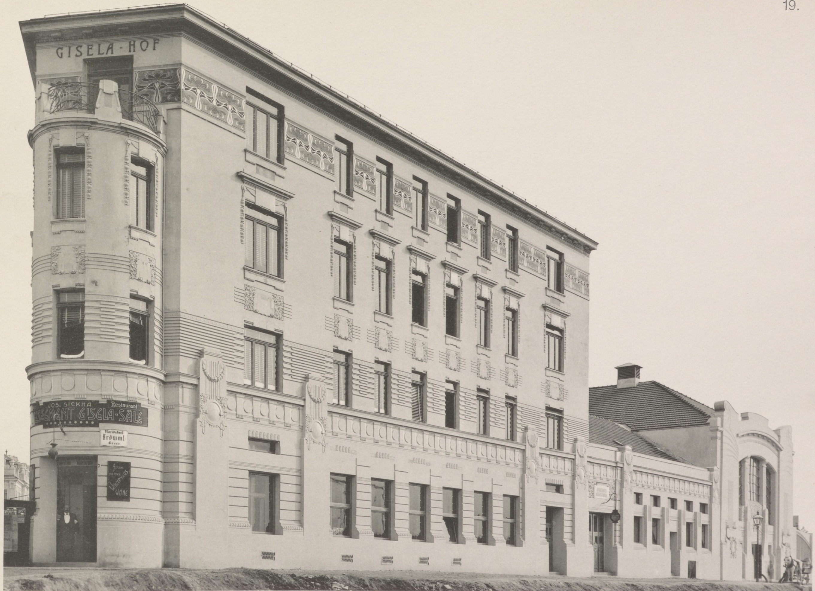
Architekt Friedr. v. Dietz „Giselahof“ und „Giselasäle“ in Wien-Floridsdorf.
