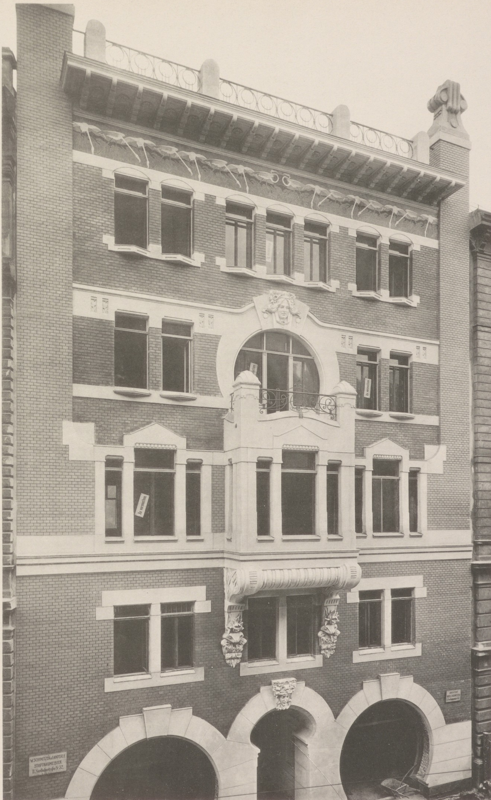
Architekt Hans Schmitzek Wohnhaus in Wien.
