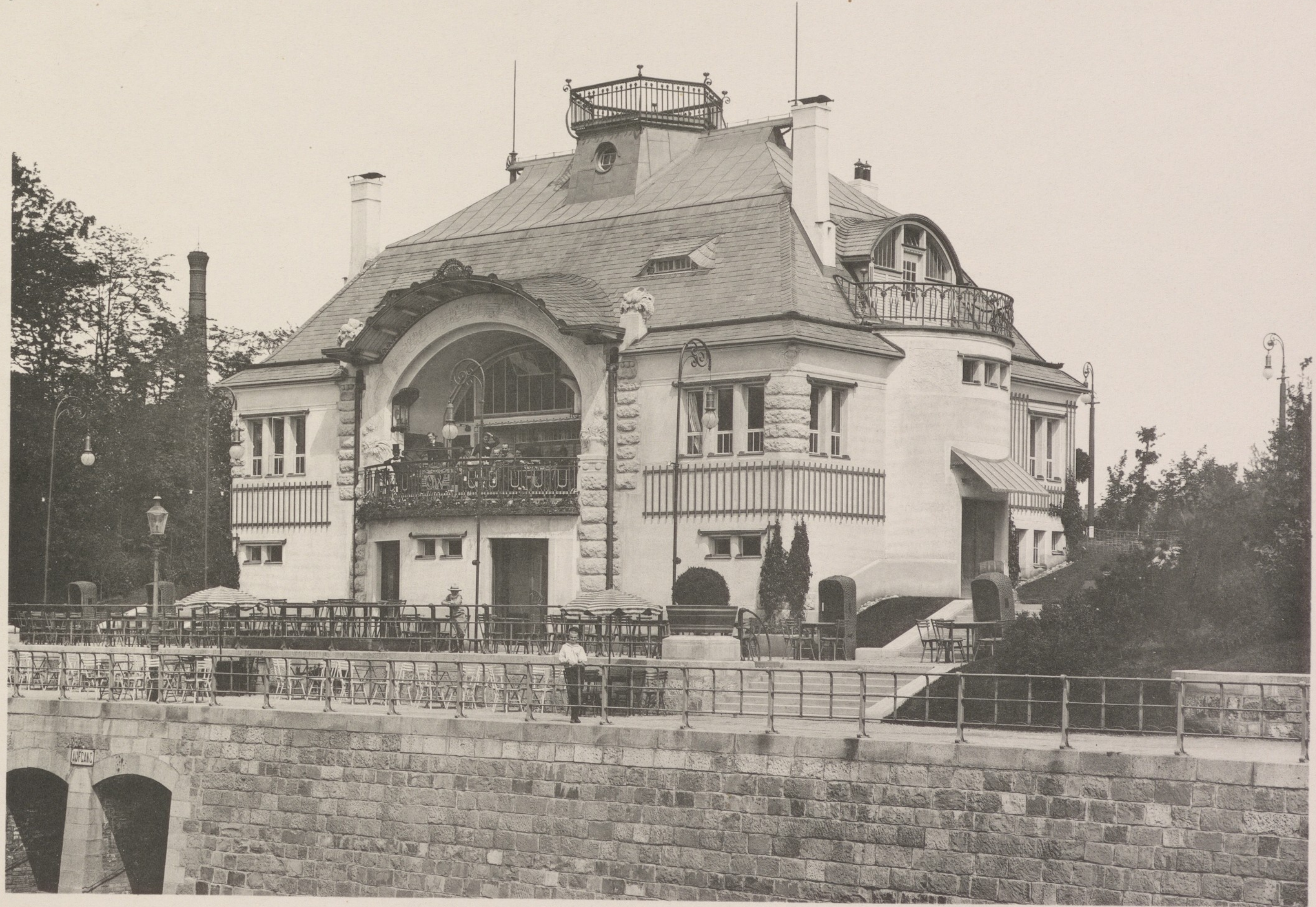
Architekten k. k. Oberbaurat Professor Friedr. Ohmann und Josef Hackhofer. Milchtrinkhalle im Stadtpark in Wien.
