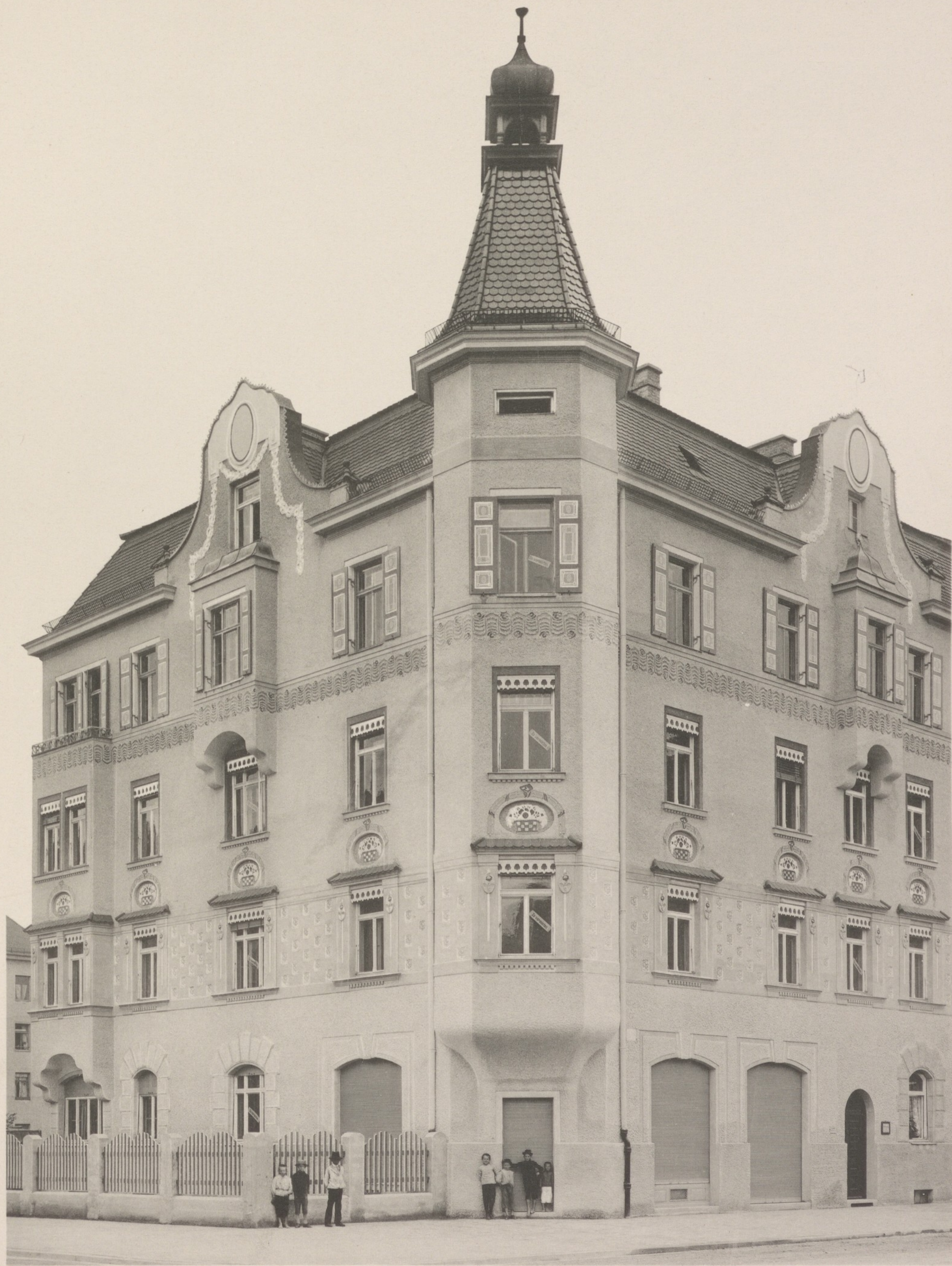
Architekten Gebr. Rank. Wohnhaus in München, Ainmüllerstrasse 42.
