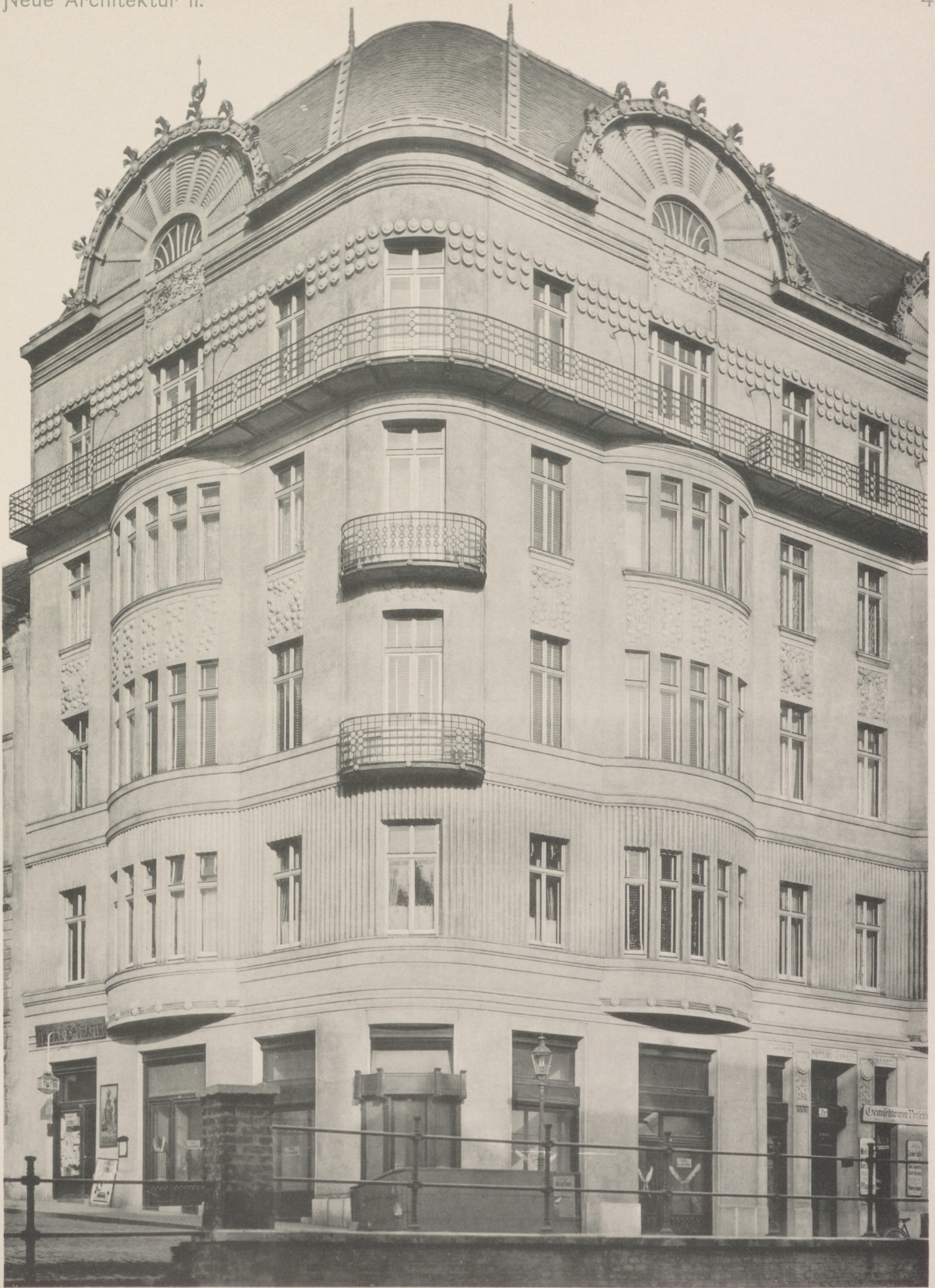
Architekt Oskar Marmorek. Wohnhaus in Wien, VI., Windmühlgasse 24 a.
