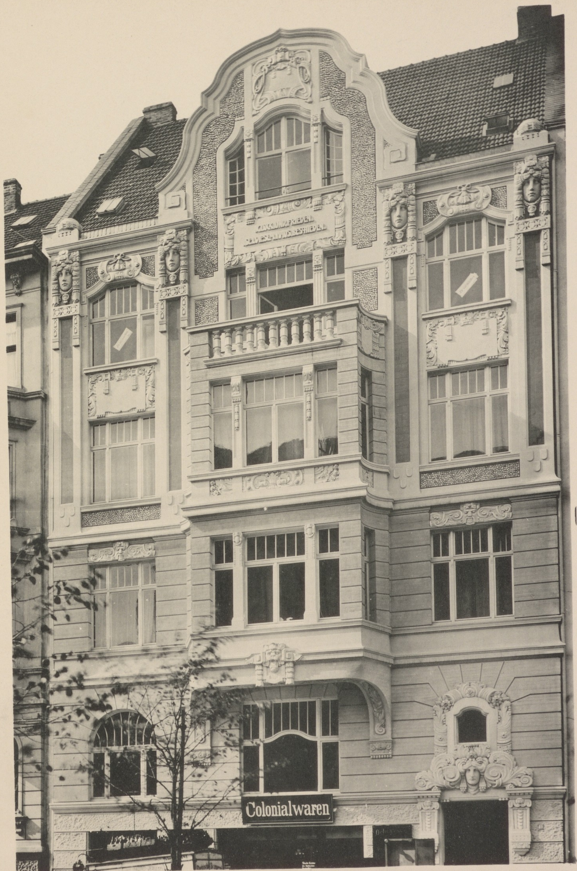
Architekt Peter Roeckerath in Köln a/Rh. Wohnhaus in Köln a/Rh., Moltkestrasse 49.
