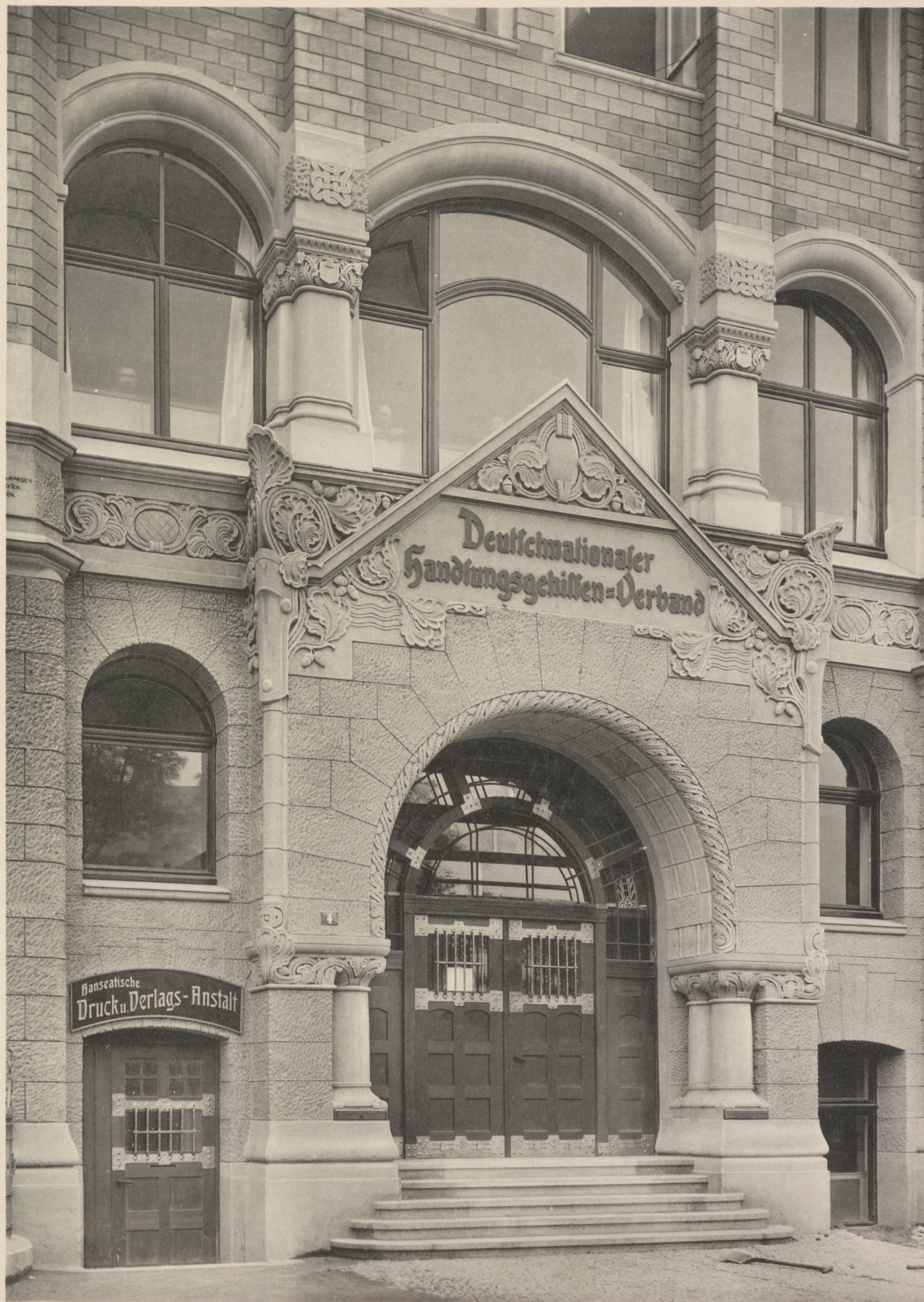
Architekten Lundt & Kallmorgen. Hamburg, Haus des deutschnationalen Handlungsgehilfen-Verbandes.
