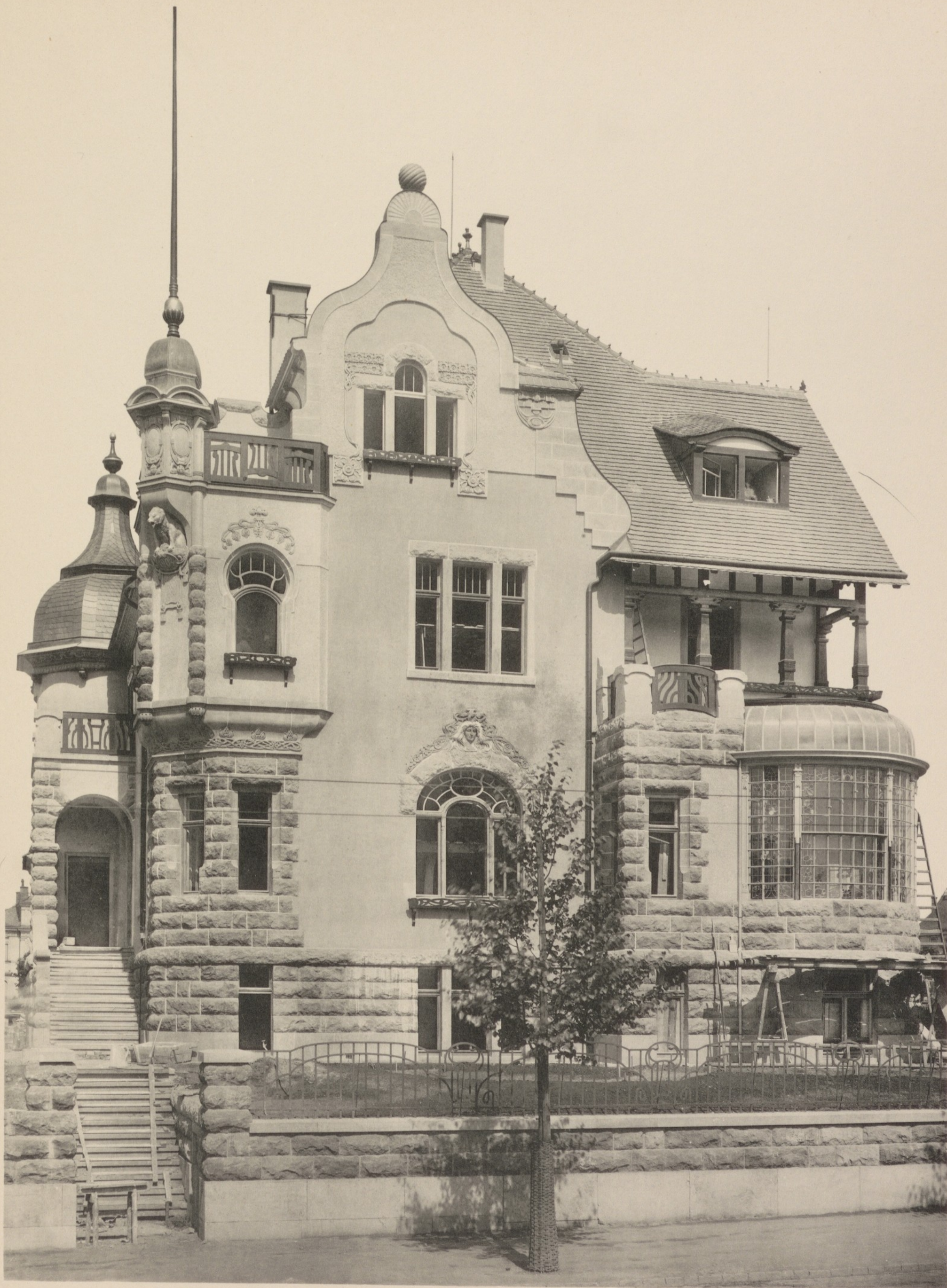
Architekt Otto Foerster. Wohnhaus in`Dresden, Palaisstrasse 8.
