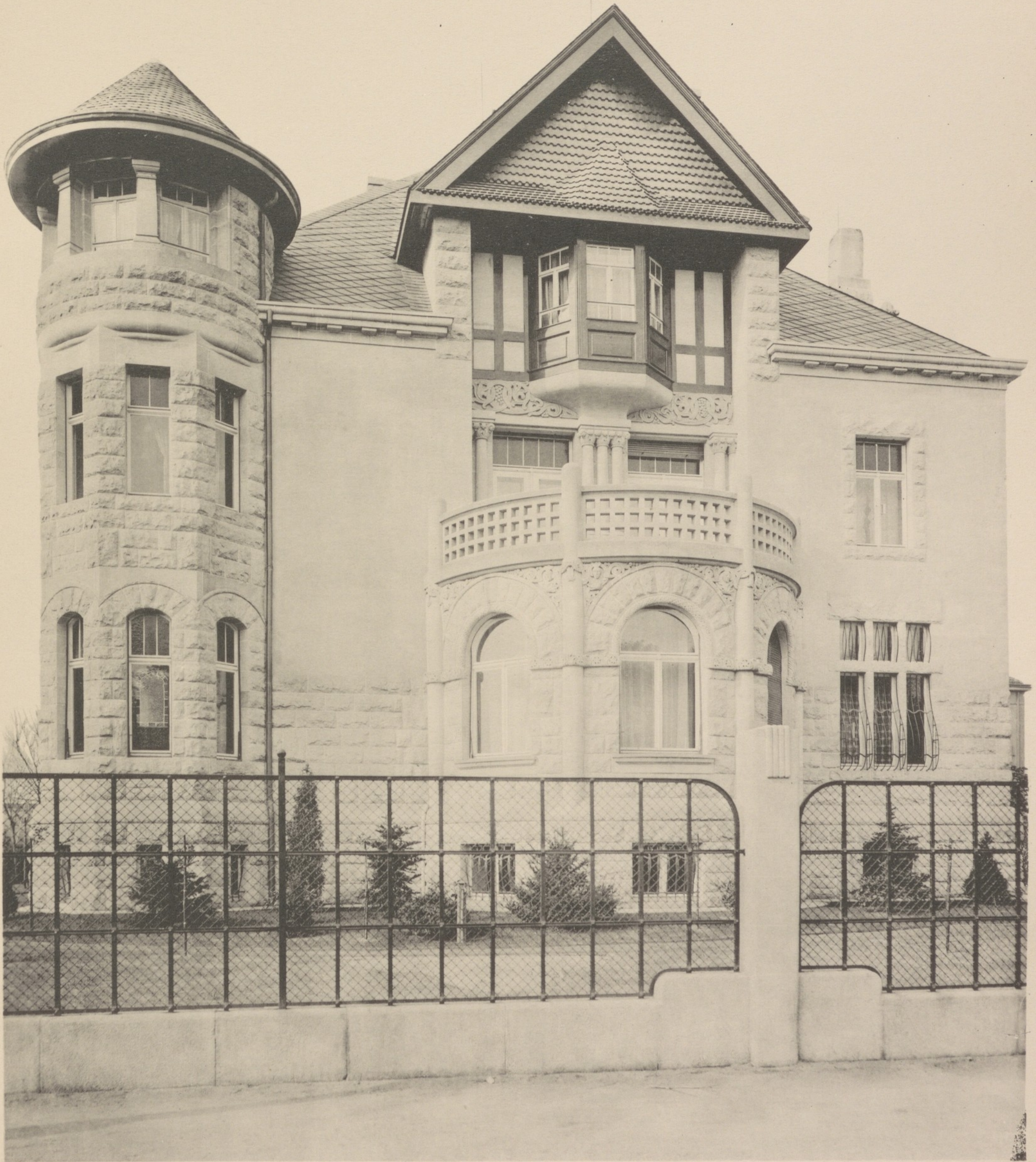
Architekten Rose & Röhle. Villa in Dresden, Thiergartenstrasse 46.
