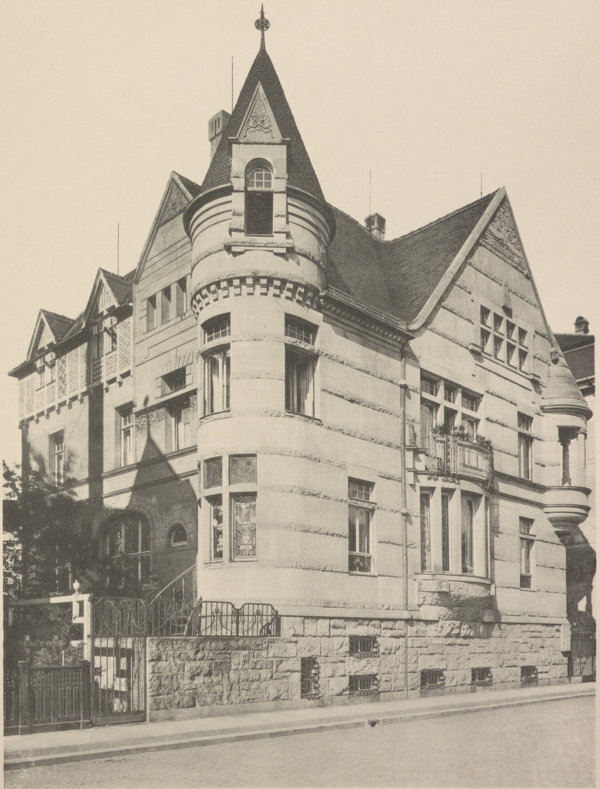
Architekt Raymund Brachmann. Villa in Leipzig, Liviastrasse 8.
