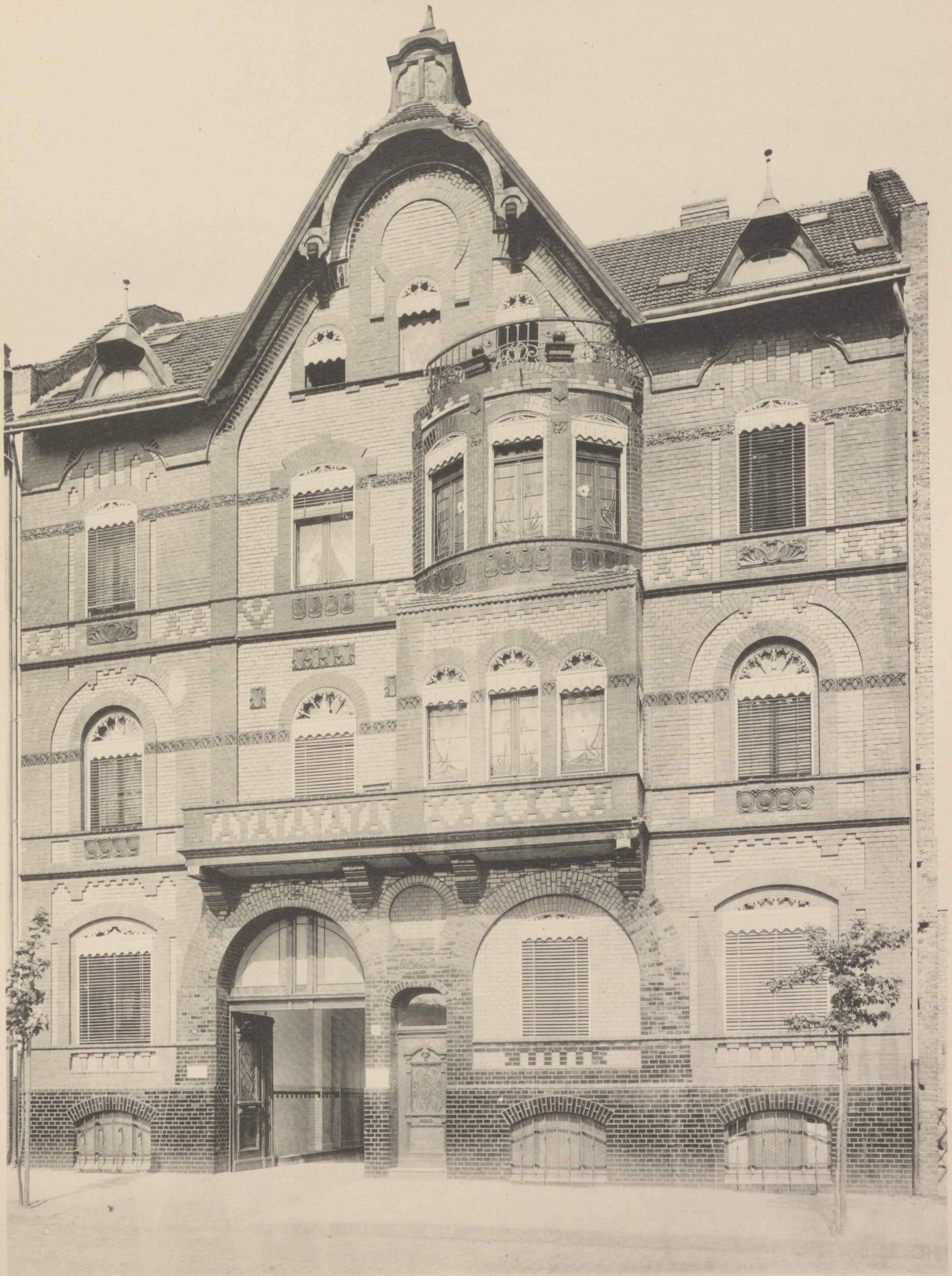
Architekten Macharacek & Giffhorn. Wohnhaus in Düsseldorf, Birkenstrasse 6.
