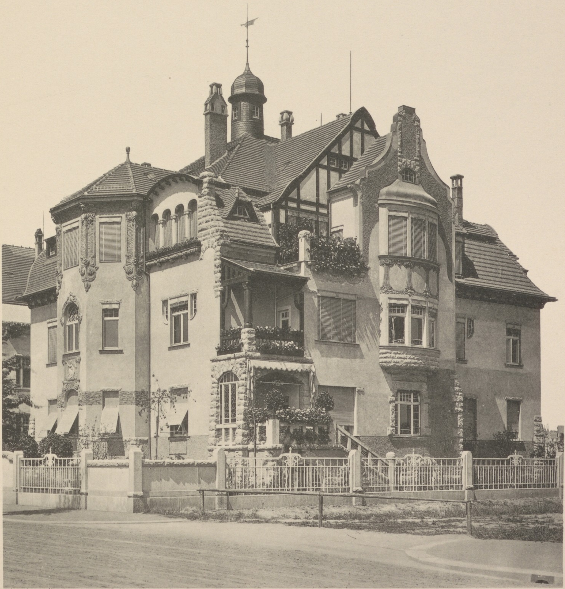
Architekt F. R. Voretzsch. Villa in Dresden, Comeniusstrasse 83.
